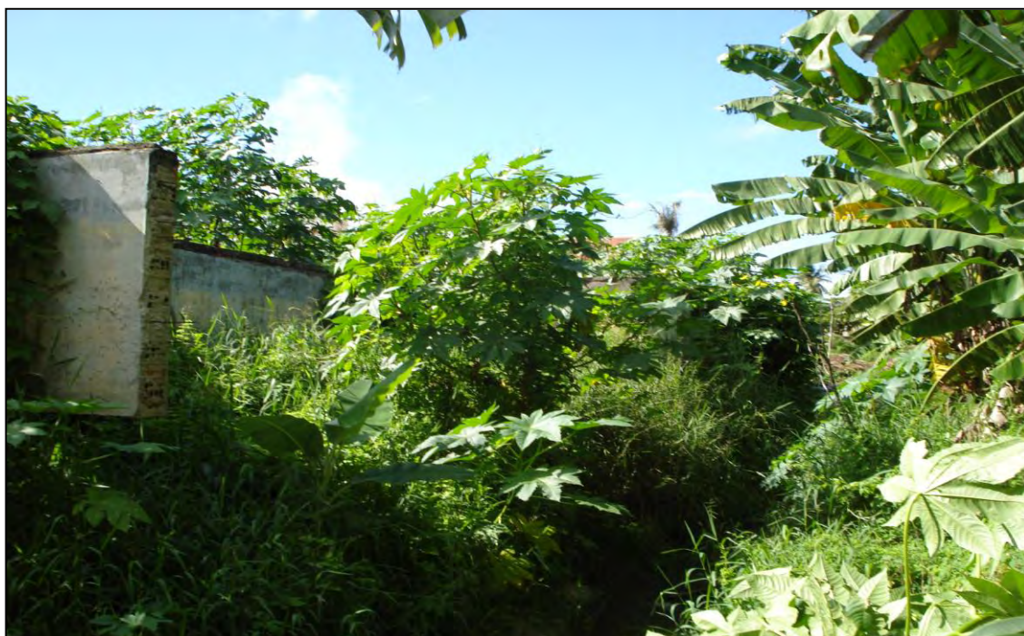
Foto 04 – Fossa pública (ruína): às margens do rio. Setembro de 2008.
