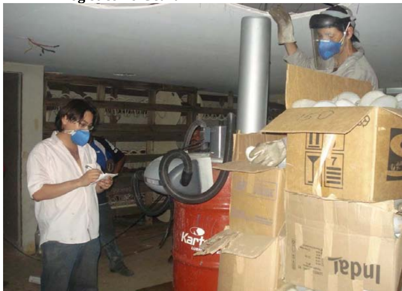
Figura 46 – Descontaminação de lâmpadas de descarga no Centro Logístico no Ceará
