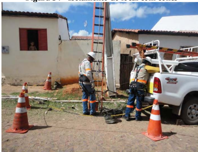
Figura 34 - Isolamento do local com cones
