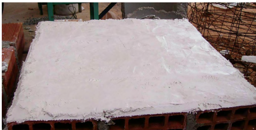
Figura 4.1- Paredes de alvenaria de tijolos furados revestidas com argamassa de gesso
