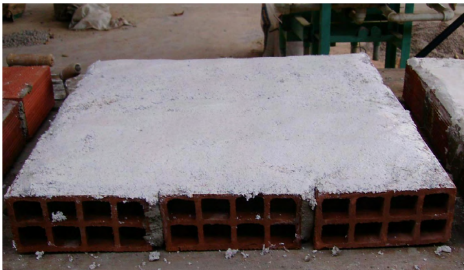
Figura 4.2- Parede de alvenaria de tijolos furados revestida com argamassa de gesso/EVA
