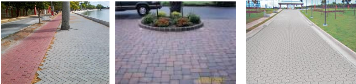
Figura 2: Aplicação dos Blocos Pré-moldados tipo paver. Fonte: Fotos da Internet.
