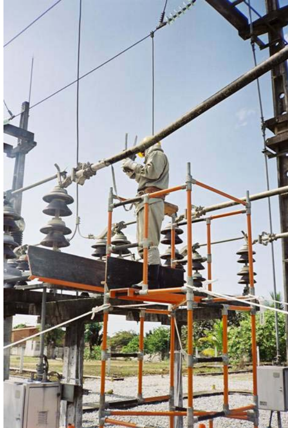
Figura 1 - Manutenção em barramento de 69 kV
