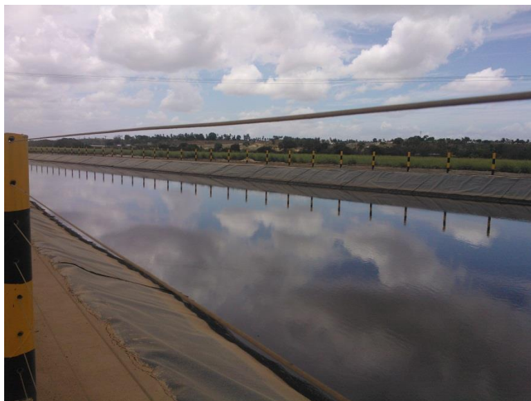
Figura 26 – Segundo tanque de resfriamento de vinhaça na usina Monte Alegre/PB
