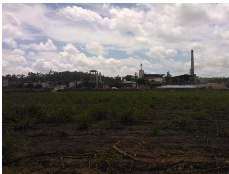
Figura 25 – Resfriamento aéreo da vinhaça da usina Monte Alegre/PB
