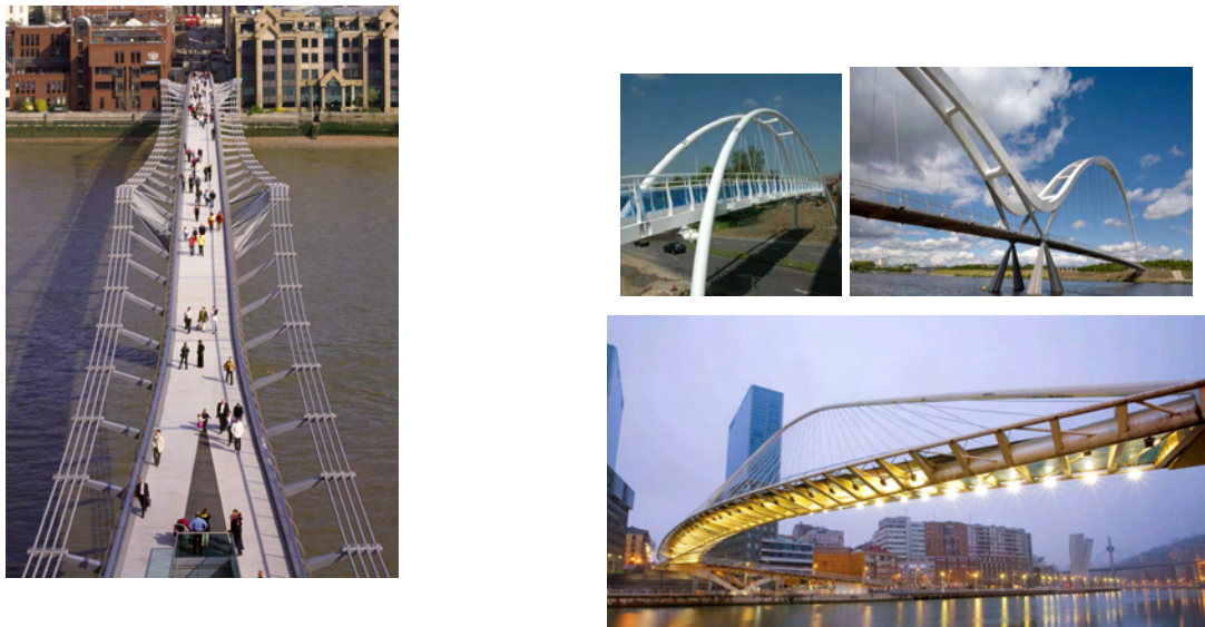
Figura 1.2 – Alguns exemplos de passarelas mais modernas.
