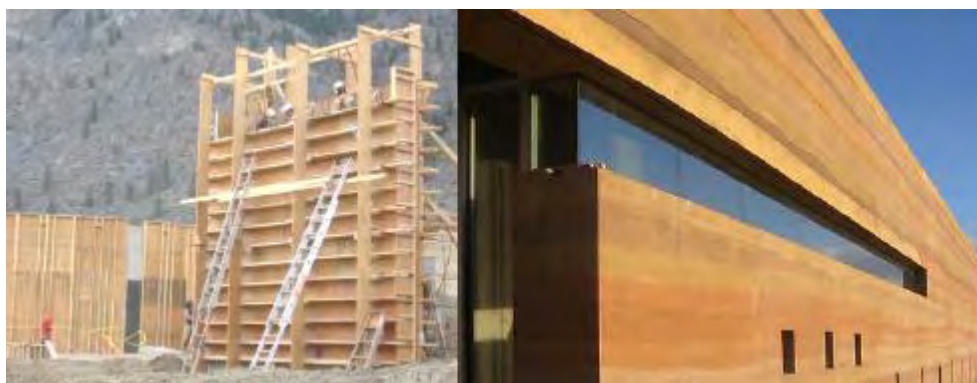
Figura 2.19 – Construção de parede e edifício em taipa mecanizada (JALALI, 2011).
