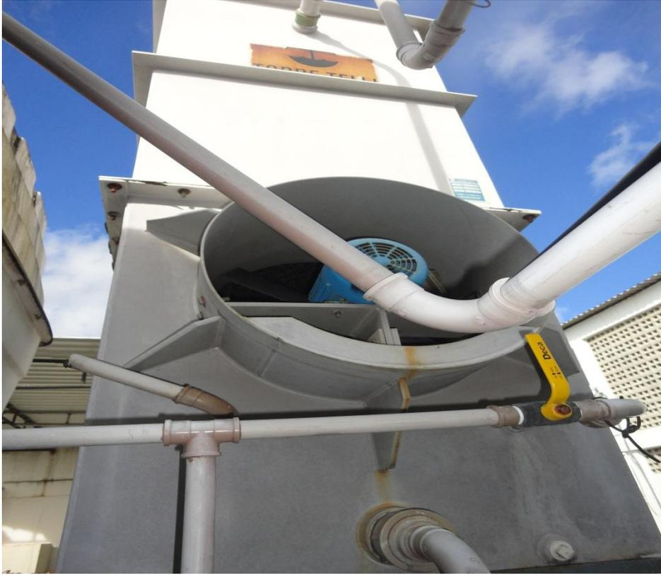
**Figura 5.6** – Vista frontal da torre de arrefecimento do absorvedor.
