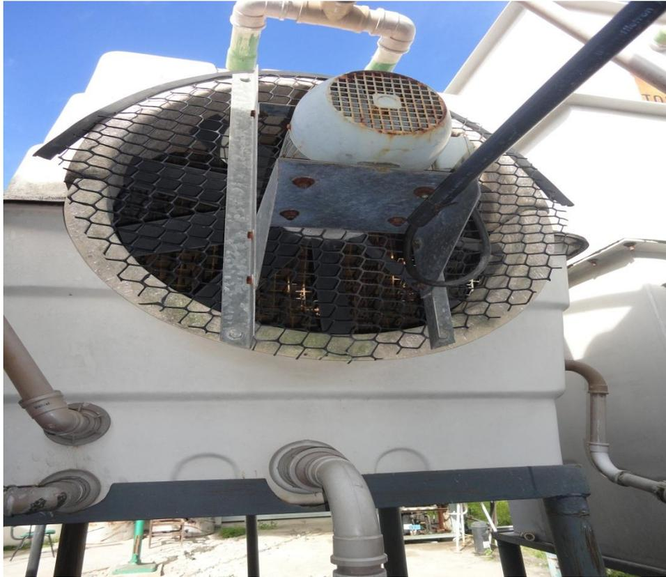
**Figura 5.8** – Vista frontal da torre de arrefecimento do absorvedor.
