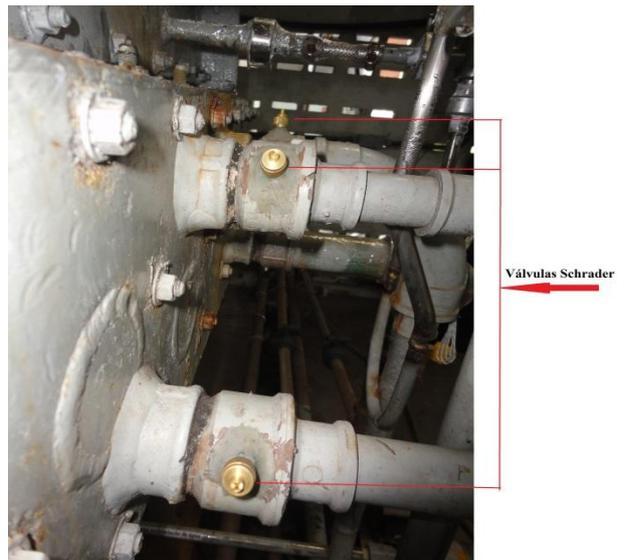
**Figura 5.23** – Instalação das válvulas.
