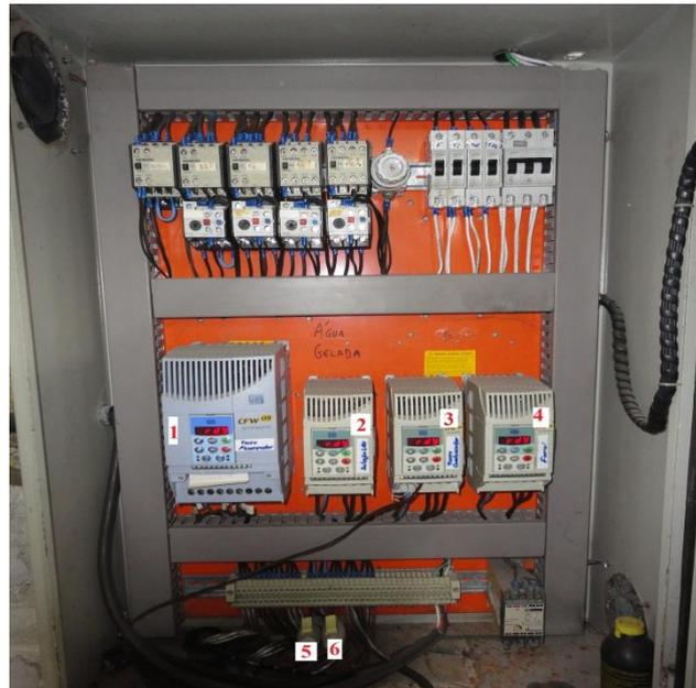
**Figura 5.19** – Inversores de frequência das bombas.
