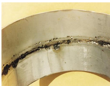
Figura 2.8 - Corrosão em tubulação de aço inoxidável em torno de cordão de solda (GENTIL, 2011).
