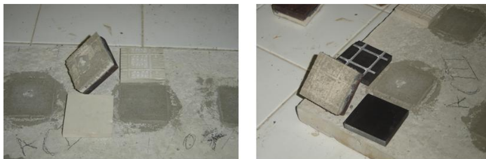
Figura 6.4: Porcelanatos colados com argamassa colante.
