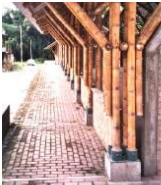
Figura 2.4 - Pilares de bambu apoiados em bases de concreto na Colômbia (TEIXEIRA, 2006).
