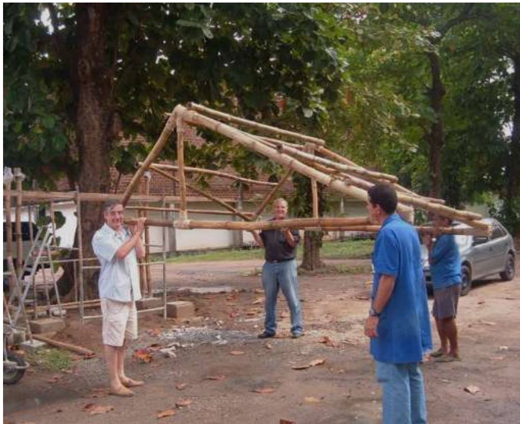
Figura 2.7 - Treliça de bambu construída na Universidade Federal da Paraíba (MEYER et al. , 2006).
