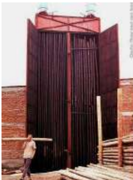
Figura 2.21 - Tratamento por fumigação (CONBAM, 2007).
