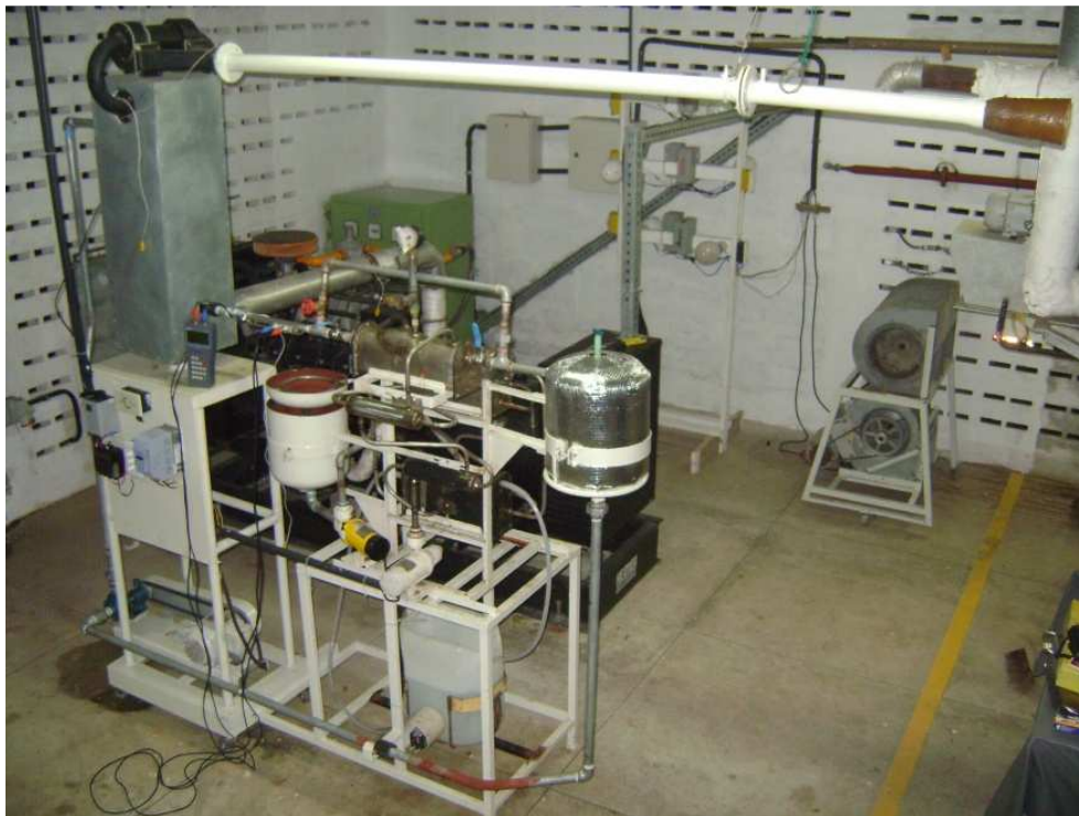
Figura 4.2 – Sistema de Cogeração do LES
