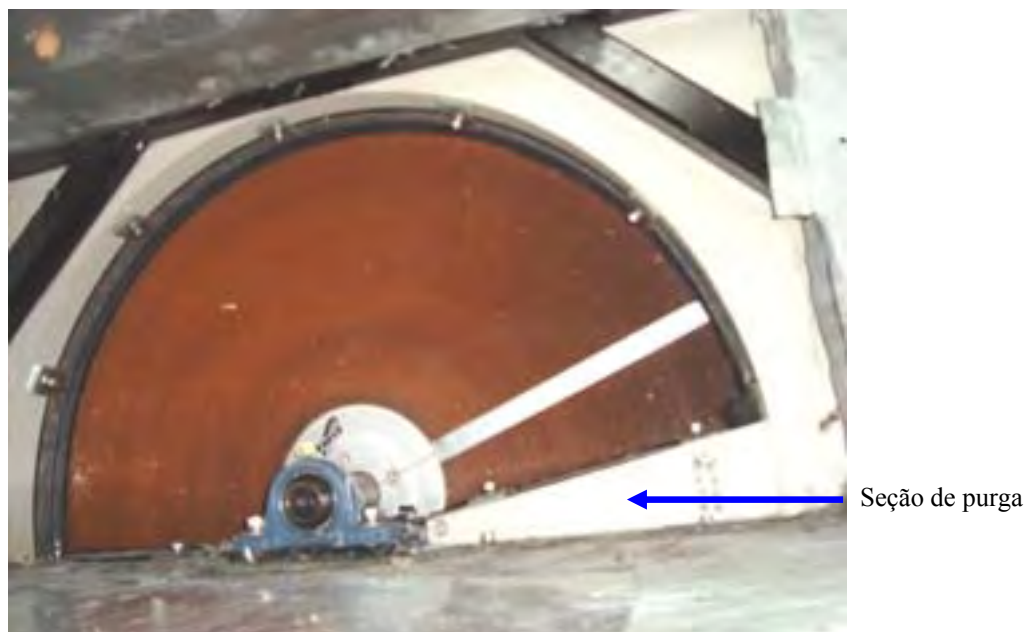
Figura 4.3. Seção de purga do rotor sensível.
