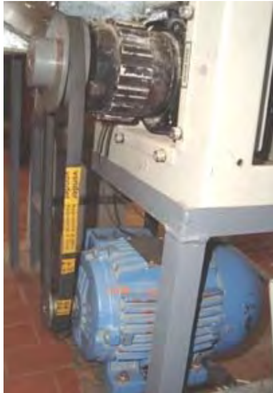
Figura 4.8. Alteração da tração dos rotores dessecantes.
