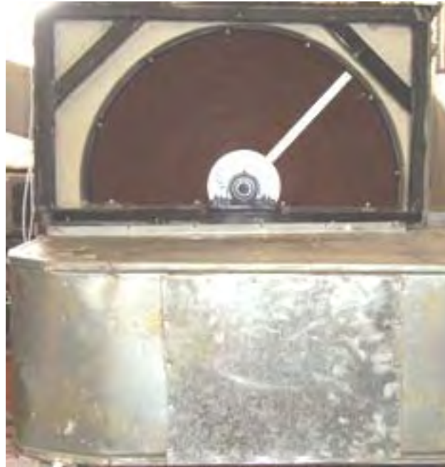
Figura 4.7. Uma etapa da troca das posições dos rotores sensíveis.
