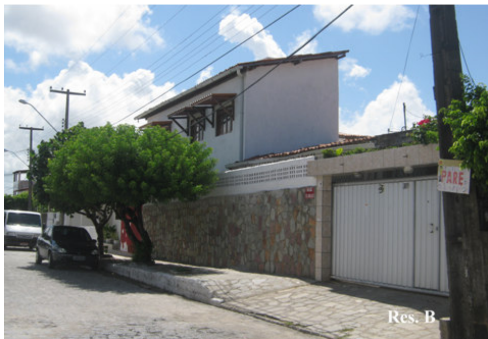
Figura 10: Ilustra a residência B, localizada no bairro 13 de Maio.
