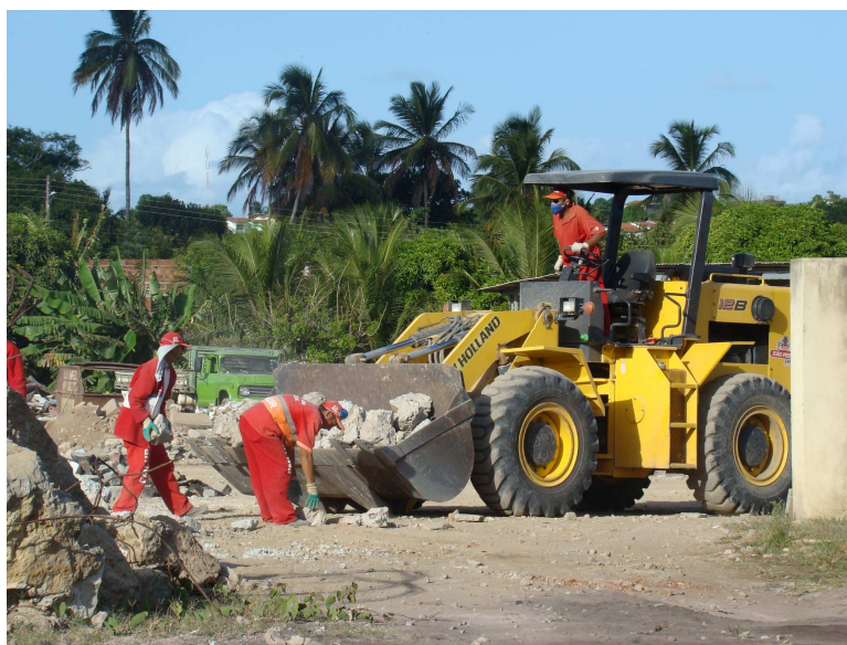
Figura 26 - Material proveniente do concreto sendo colocado no trator
