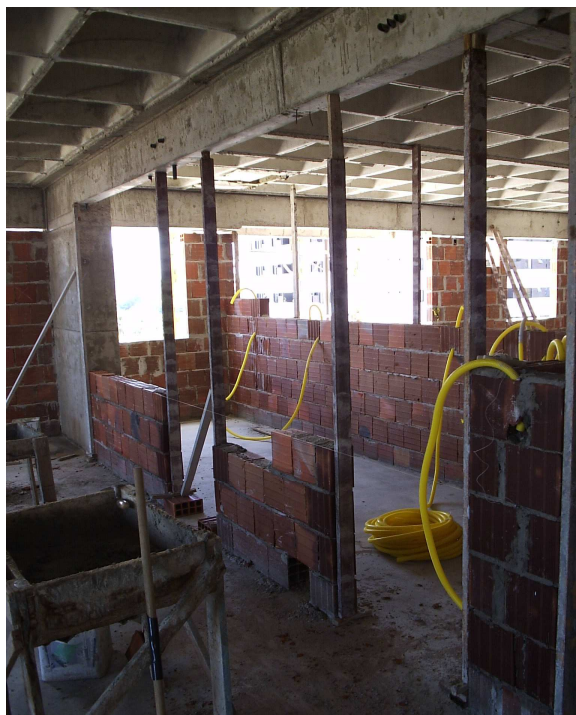
Figura 14 - Execução de alvenaria sem rasgos e sem resíduos
