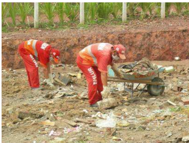
Figura 24 - Triagem dos RCD que entram na Usina
