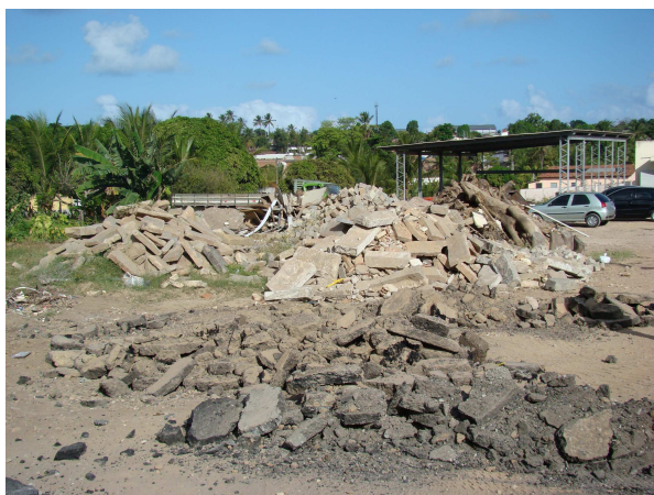
Figura 18 – Resíduos classe A de pavimentação e demolição de peças pré-moldadas de concreto
