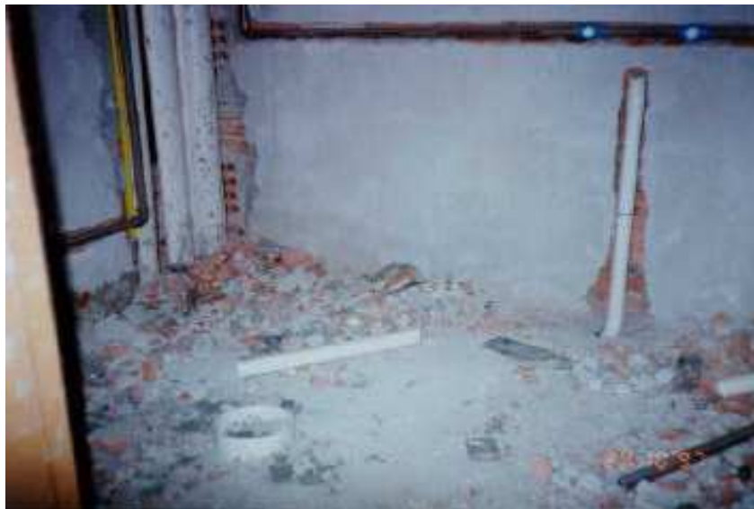
Figura 12 - Geração de entulho durante a execução de rasgos nas paredes para se embutir as instalações elétricas, hidráulicas e sanitárias.
