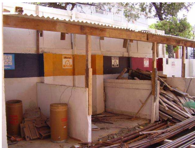
Figura 49 – Baias para acondicionamento dos resíduos em canteiros
