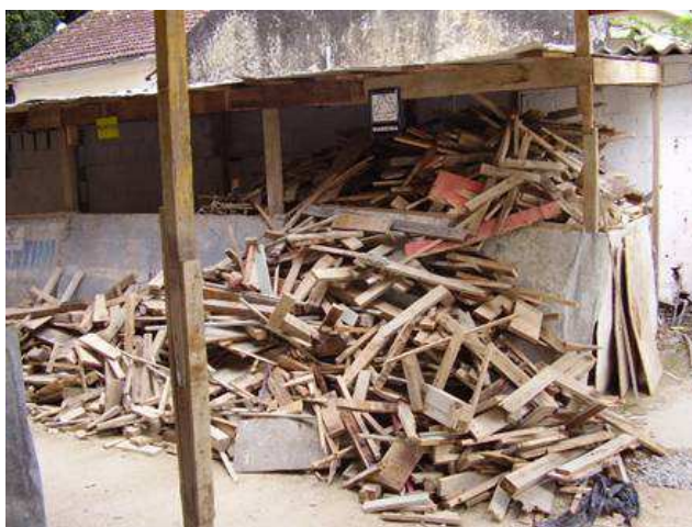
Figura 50 – Capacidade de acondicionamento ultrapassada
