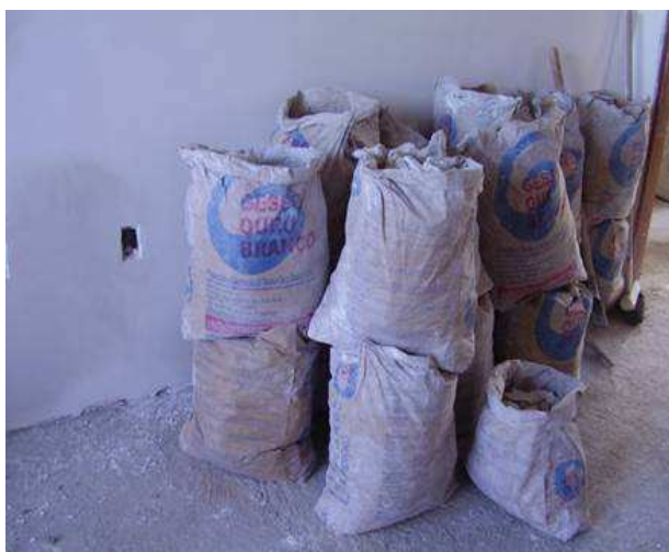
Figura 46 – Resíduo de gesso armazenado inicialmente nos próprios sacos da embalagem original.
