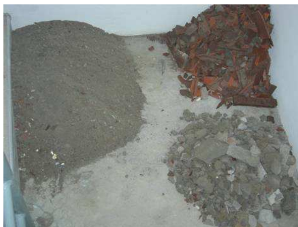
Figura 37 - Resíduos de Construção após a Separação
