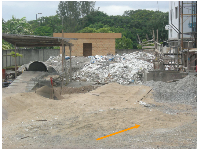
Figura 06– Mistura de agregados impossibilitando sua utilização.
