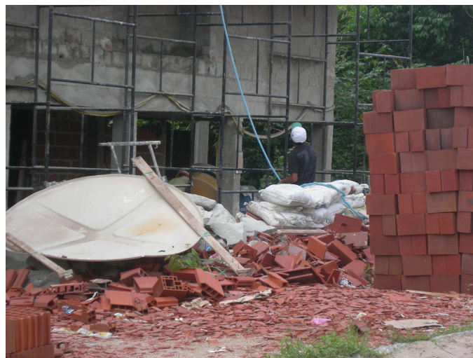
Figura 10 - Desperdício de blocos cerâmicos
