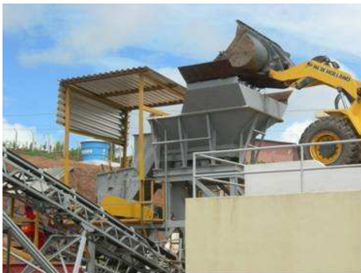
Figura 27 - Lançamento do material na máquina de beneficiamento
