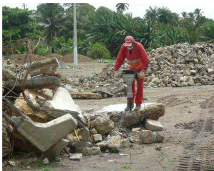
Figura 25 - Material proveniente do concreto sendo quebrado
