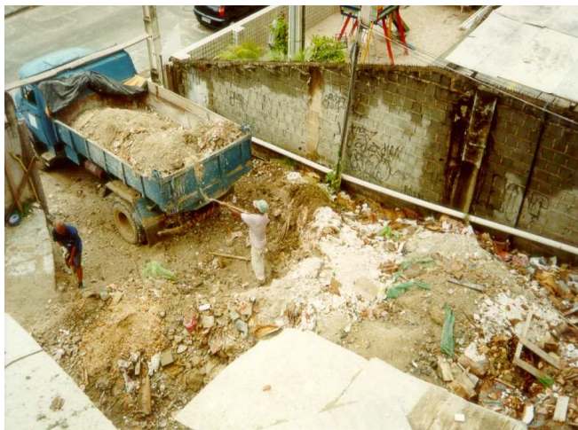
Figura 02 - Retirada de grande volume de entulho
