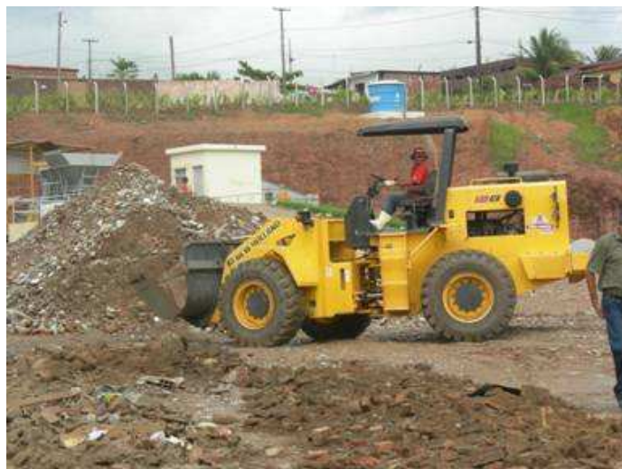
Figura 30 - Carregamento do trator com o material não concretício
