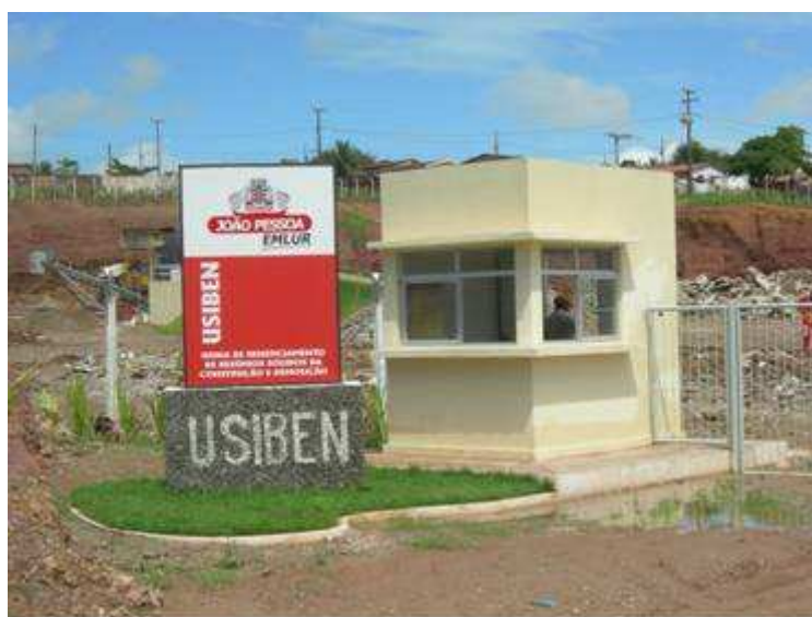
Figura 22 - Usina de Beneficiamento
