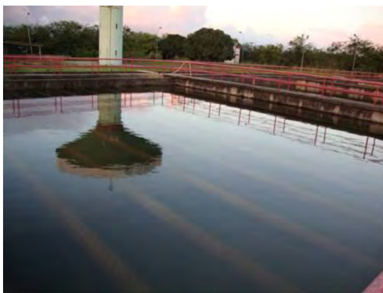
Figura 10 - Decantador atual da ETA.
