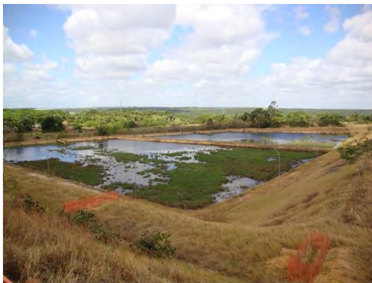
Figura 23 - Lagoas de lodo da ETA/Gramame.
