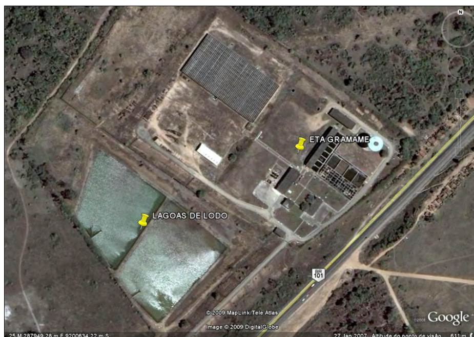
Figura 18 - ETA Gramame e lagoas de lodo.
