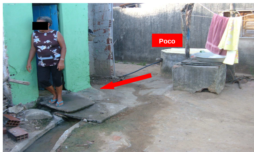
Figura, 6.6 – Lat. 266561 Long. 9181488 – Proximidade entre o poço e o sanitário
