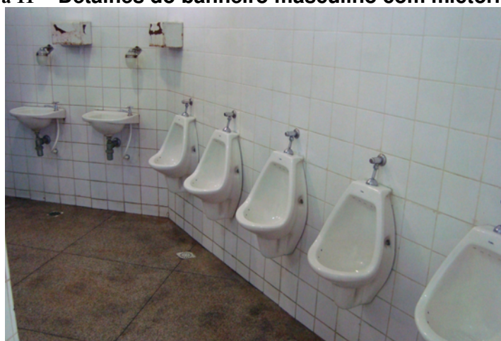
Figura 11 – Detalhes do banheiro masculino com mictórios
