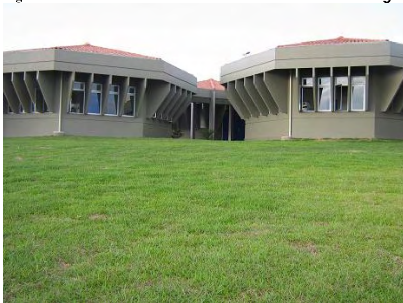
Figura 16 - Vista externa dos blocos de salas de aula e gramados
