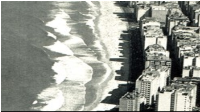
FIGURA 15: Av. Atlântica antes do alargamento (1965 – 1970)
