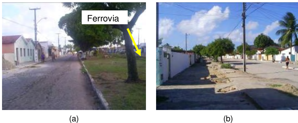
Figura IV.4 – (a) Vista da Rua Cleto Campelo, detalhe da locação da ferrovia; (b) Vista da Rua Siqueira Campos.
