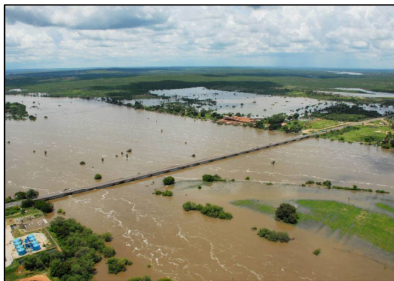
Figura 15 – Ponte no município de Açú inundada
