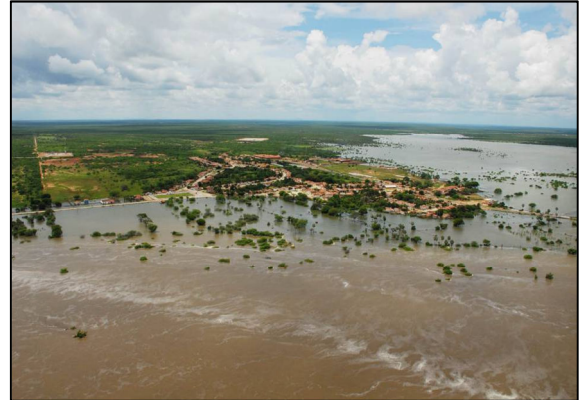
Figura 20 – Parte do núcleo urbano de Pendências inundado
