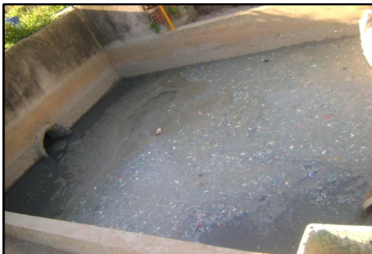
Figura 11- Tanque de lavagem na empresa
