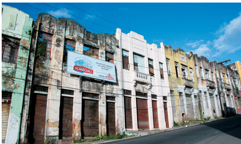
Figura 70: Imagem dos Imóveis doados a PMJP para a realização do Programa Moradouro.
