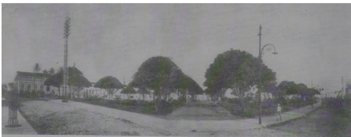
Figura 19: Imagem retirada no ano de 1920 mostrando o detalhe da Praça Pedro Américo, vendo-se ao fundo o casario onde se ergueu o edifício dos Correios e Telégrafos. Fonte: Parahyba - Capital em fotos.
