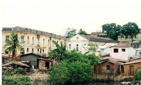
Figura 41: Imagem da situação insalubre de moradia das famílias residentes à margem do Rio Sanhauá no complexo do Porto do Capim. Fonte: Prefeitura Municipal de João Pessoa – SEMHAB.
