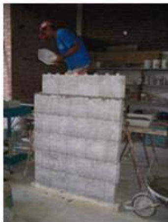
d) assentamento do meio bloco
