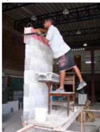
g) Execução viga de concreto
