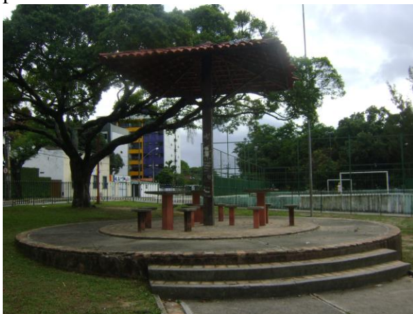
Figura 40: Equipamento inacessível pelo deficiente ou pessoa com mobilidade reduzida – ausência de rampa. Fonte: Acervo pessoal.
