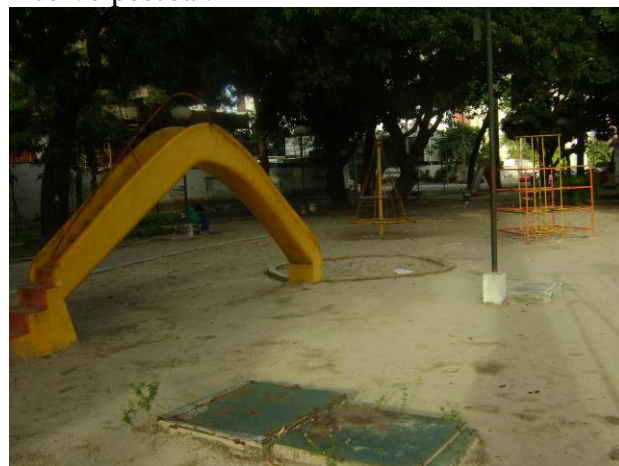
Figura 29: Detalhe do escorrego faltando corrimão e tampas enferrujadas. Fonte: Acervo pessoal.
