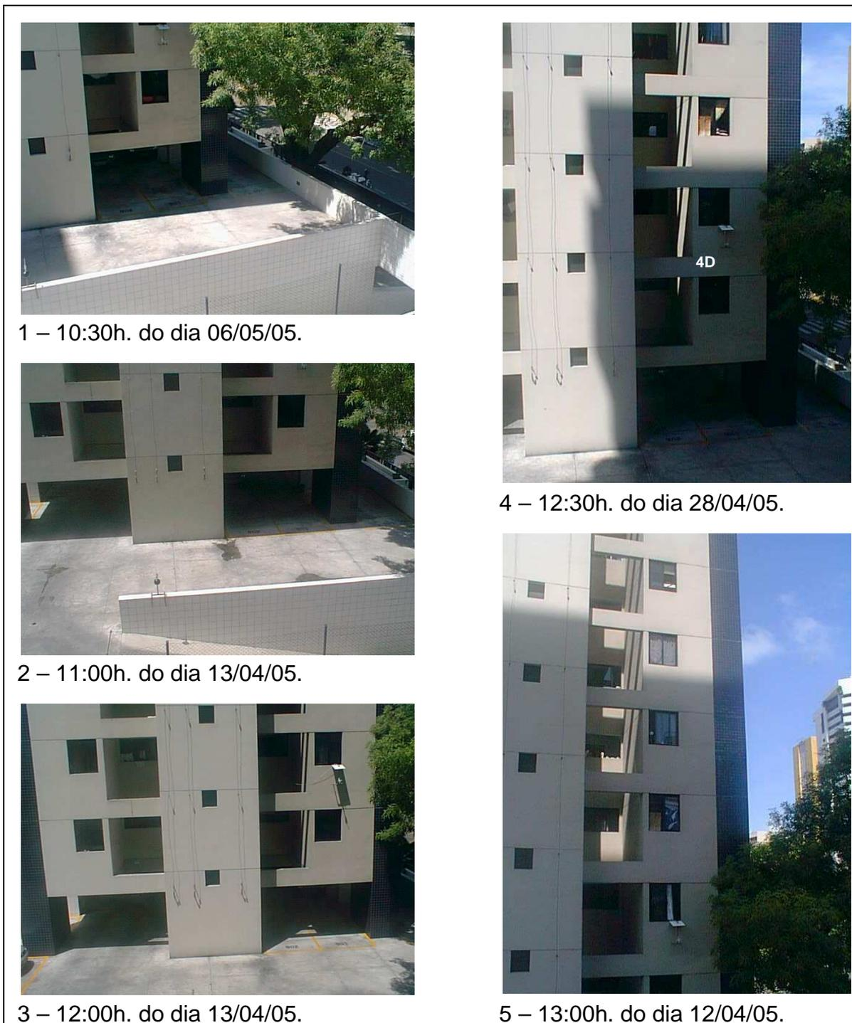
**Figura 48:** Comportamento da radiação solar direta e sombreamento sobre o ponto 4D da fachada de 10:30h. às 13:00h.
