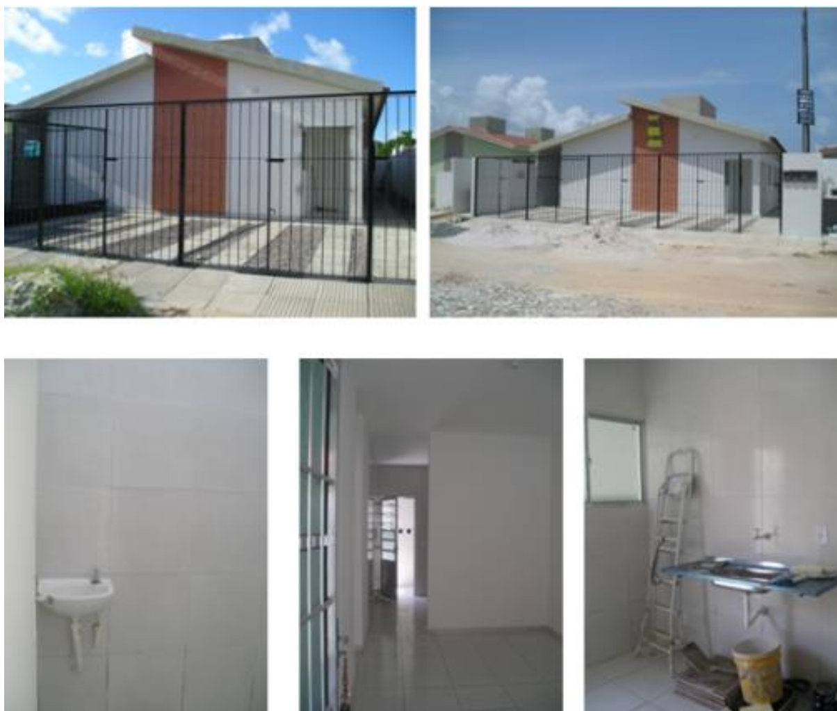
Figura 18 - Fachada e vistas internas do imóvel - Tipologia 01
