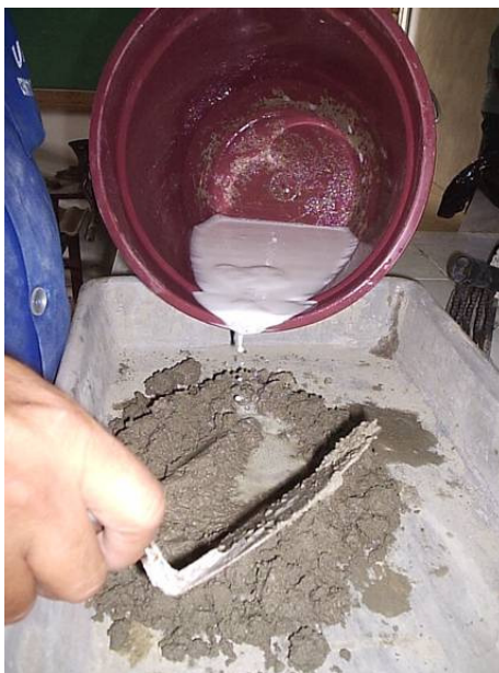
Figura 3.3 - Preparação da argamassa para chapisco.
