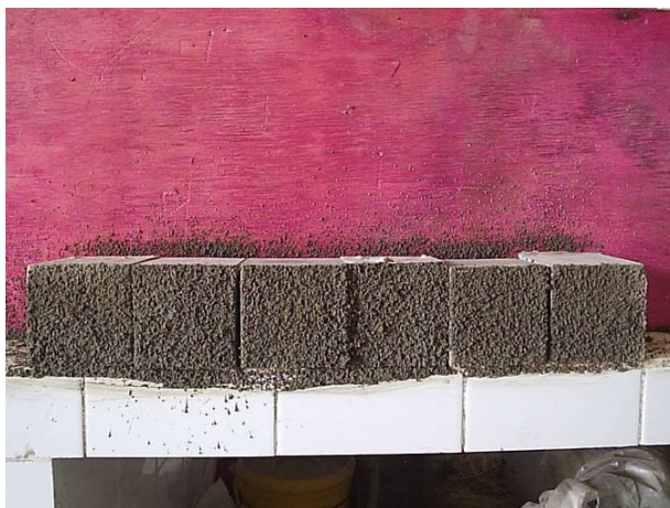
Figura 3.5 - Aspecto uniforme do chapisco aplicado manualmente com o auxílio da colher de pedreiro e da peneira de malha fina.
