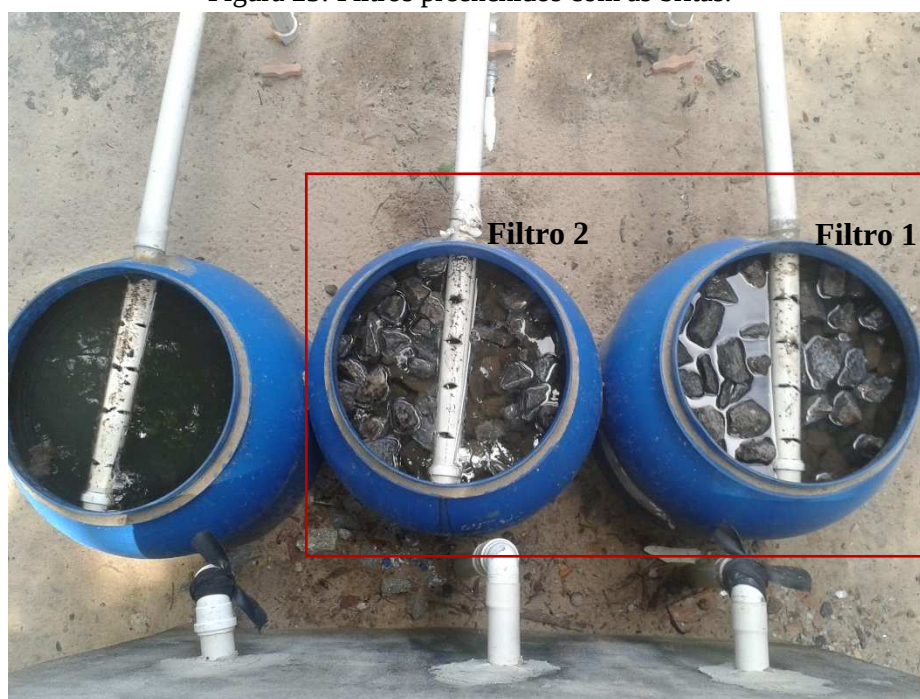
Figura 23: Filtros preenchidos com as britas.
