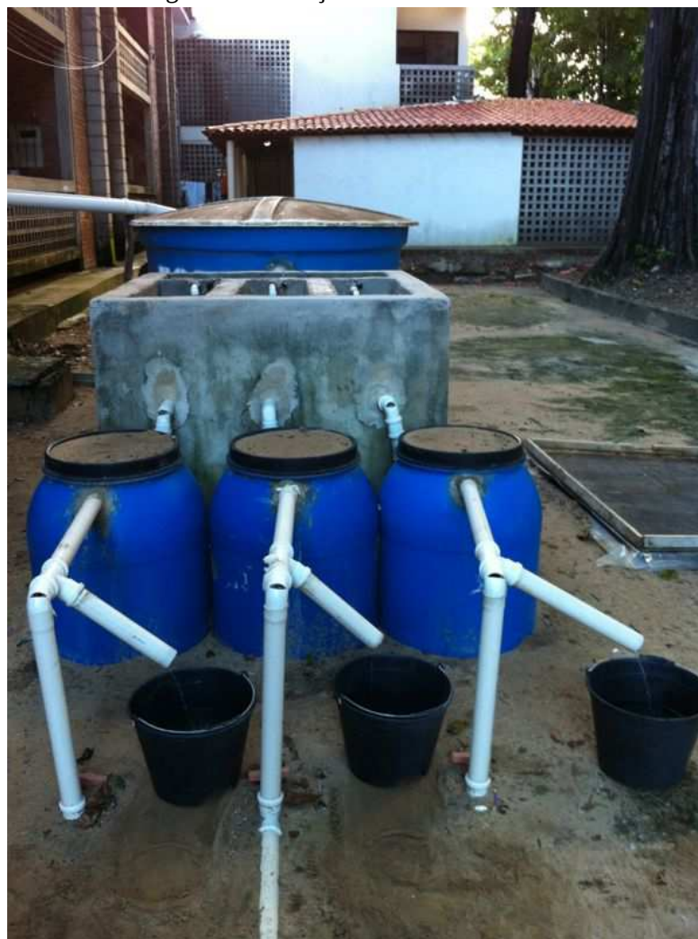
Figura 30: Medição da vazão dos filtros.
