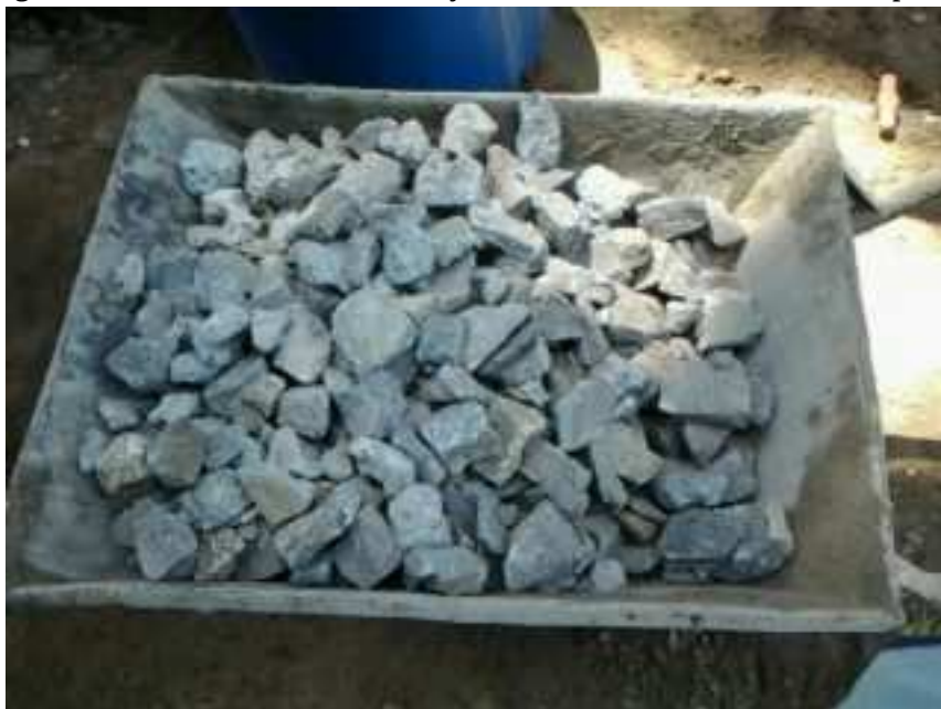
Figura 22: Britas obtidas de demolição utilizadas como material de suporte.
