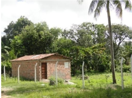
Figura 1.1 - Residência construída em 2013 na nascente do rio Cuiá, Grotão, João Pessoa-PB.
