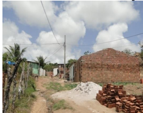
Figura 10.18 - Construções iniciadas em 2013. Continuidade da rua principal da Comunidade.
