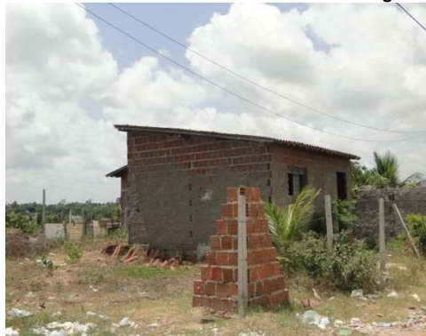
Figura 10.21 – Residência construída em 2013. Rua sem nome, João Pessoa-PB.
