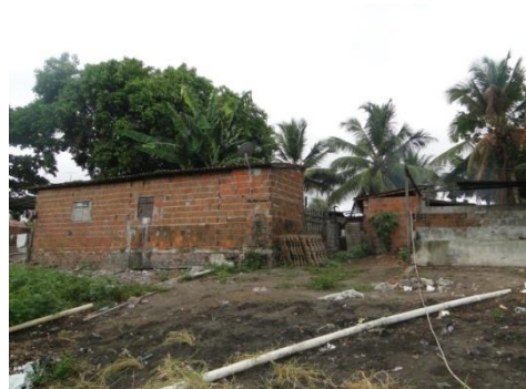
Figura 5.46 - Residência construída na margem do rio Cuiá, João Pessoa-PB.
