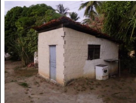
Figura 4.40 - Edícula localizada nos fundos da residência (Figura 4.39).
