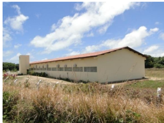
Figura 71 - EMEPA/PB. Rodovia Ministro Abelardo Jurema - Jacarapé III, João Pessoa-PB. Fonte: Anjos, 2013.
