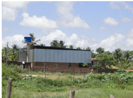
Figura 3.24 - Fabrica de gelo. Rua Sebastião Renato de Melo, João Pessoa-PB.
