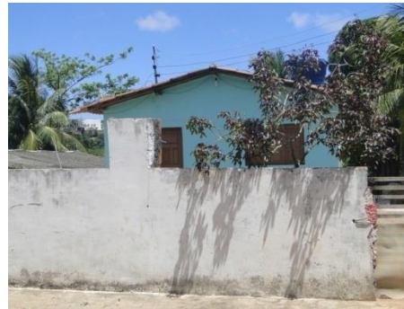
Figura 4.11 – Residência. Rua sem nome paralela ao rio Cuiá, João Pessoa-PB.
