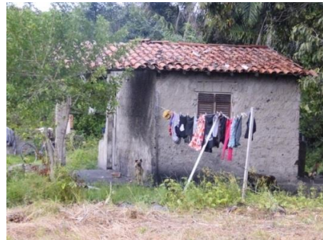
Figura 4.22 – Residência. Rua sem nome, perpendicular a Rua Sebastião R. de Melo, João Pessoa-PB.
