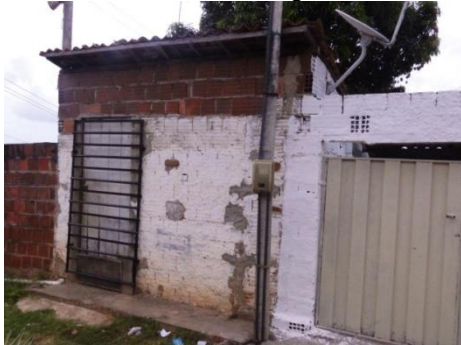
Figura 6.9 - Residência. Rua sem nome perpendicular a Rua Brasilino Alves da Nóbrega, João Pessoa-PB.
