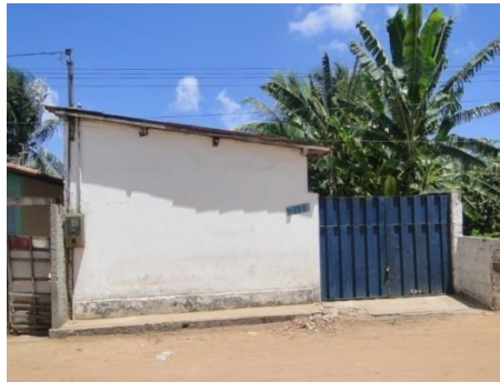
Figura 4.15 – Residência. Rua sem nome paralela ao rio Cuiá, João Pessoa-PB.
