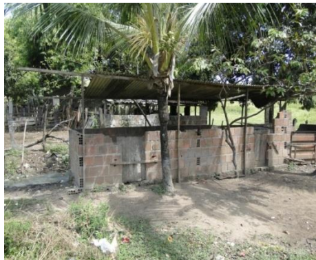
Figura 1.10 - Pocilga construída na APP do rio Cuiá. Rua Cecília Furtado da Silva, Gramame, João Pessoa-PB.
