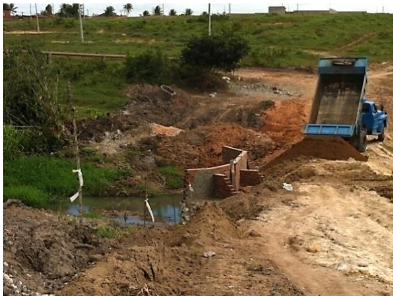
Figura 31 - Construção de obra d'arte na APP da bacia do rio Cuiá. Bairro dos Funcionários, João Pessoa-PB. Fonte: Anjo, 2012.
