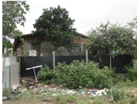
Figura 5.42 - Residência construída na margem do rio Cuiá, João Pessoa-PB.
