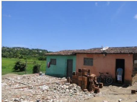
Figura 4.21 - Residências e alicerce iniciado em 2013 para construção de residência. Rua sem nome paralela ao rio Cuiá, João Pessoa-PB.
