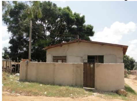
Figura 10.14 - Residência. Rua sem nome perpendicular a Rua Profº Arlindo B. Camboim João Pessoa-PB.
