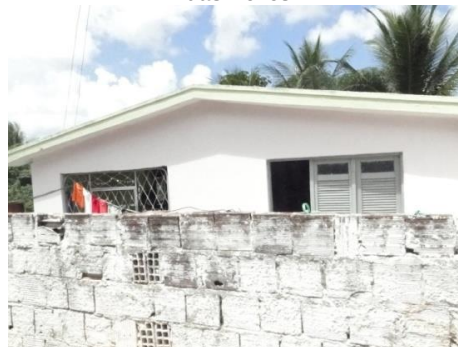
Figura 3.38 - Residência construída em APP. Rua Sebastião R. de Melo, João Pessoa-PB.
