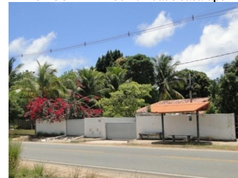
Figura 12.12 - Residência. Rodovia Ministro Abelardo Jurema. Jacarápé, João Pessoa-PB.
