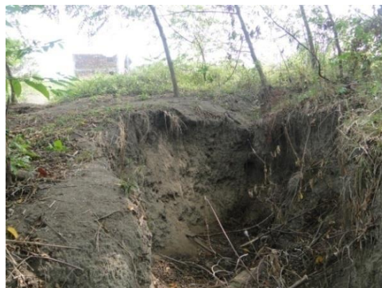
Figura104 - Voçoroca na margem esquerda do rio Cuiá. Mangabeira IV, João Pessoa-PB. Fonte: Anjos, 2013.
