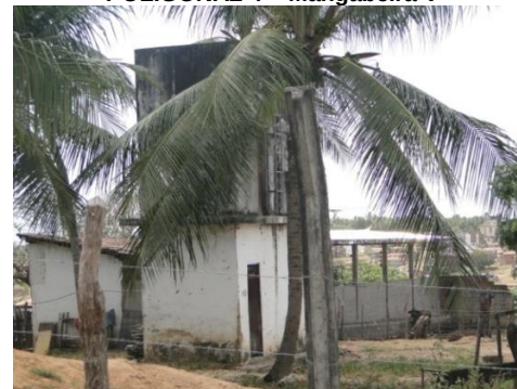
Figura 10.26 - Caixa d'água, residências e galpão. Rua sem nome paralela a Estação de Tratamento de Esgoto, João Pessoa-PB.
