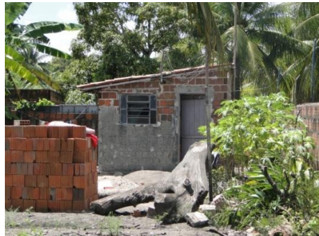
Figura 3.13 - Edícula - Construída nos fundos da residência (Figura 3.12).
