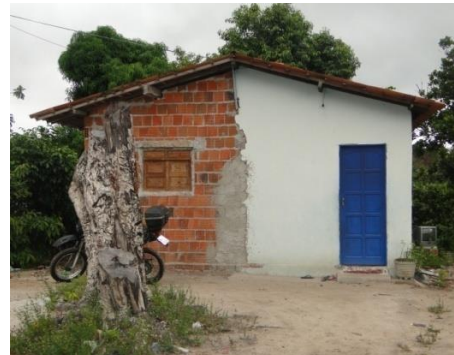
Figura 5.39 - Residência construída em APP. Rua sem nome, perpendicular a Rua Luiz T. de Souza, João Pessoa-PB.
