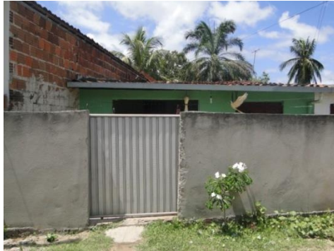
Figura 4.25 - Residência. Rua sem nome perpendicular a Rua Sebastião Renato de Melo, João Pessoa-PB.
