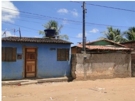
Figura 4.17 – Residências. Rua sem nome paralela ao rio Cuiá, João Pessoa-PB.
