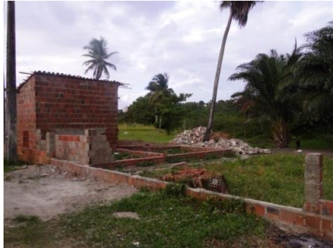
Figura 4.29 - Construção de residência iniciada em 2013. Rua sem nome, perpendicular Rua Sebastião R. de Melo, João Pessoa-PB.
