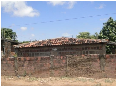
Figura 4.9 – Residência. Rua sem nome paralela ao rio Cuiá, João Pessoa-PB.
