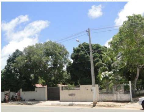
Figura 12.15 - Residência. Rodovia. Ministro Abelardo Jurema, Jacarápé, João Pessoa – PB.
