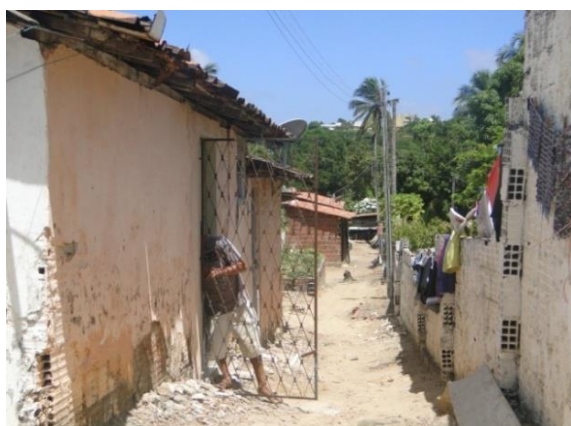
Figuras 53 - Residência com edículas. Comunidade Frei Damião, João Pessoa-PB. Fonte: Anjos, 2013.
