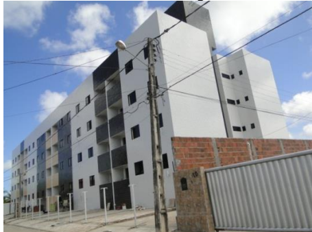
Figura 5.17 - Prédio residencial em fase de conclusão - Térreo mais três pavimentos. Rua Luiz T. de Souza, João Pessoa-PB.
