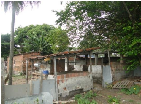
Figura 5.45 - Pocilgas construídas na margem do rio Cuiá, João Pessoa-PB.
