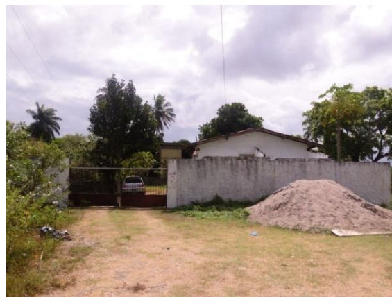
Figura 43 - Estação Elevatória da CAGEPA. Bairro do Cuiá, João Pessoa-PB. Fonte: Anjo, 2013
