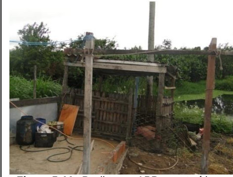
Figura 5.44 - Pocilga em APP, construída na margem do rio Cuiá, João Pessoa-PB.
