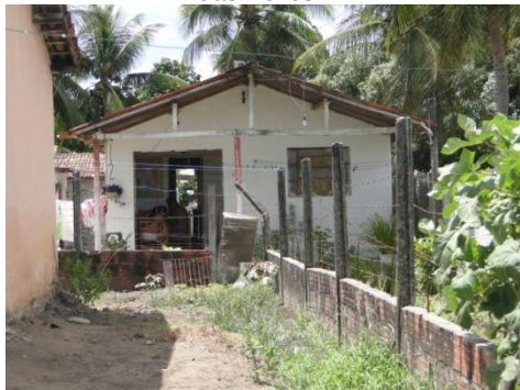
Figura 3.17 - Residência - Construída nos fundos da residência (Figura 3.16).
