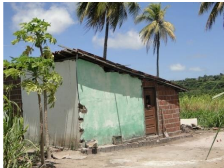
Figura 3.44 – Residência. Rua perpendicular a Rua Sebastião R. de Melo, João Pessoa-PB.
