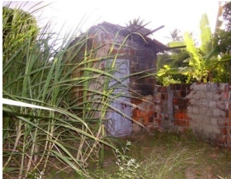
Figura 4.41 - Depósito localizado nos fundos da residência (Figura 4.40).
