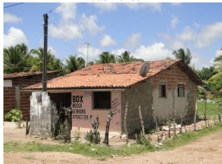
Figura 3.30 - Residência com comércio. Rua Sebastião Renato de Melo com Nossa Senhora das Neves, João Pessoa-PB.
