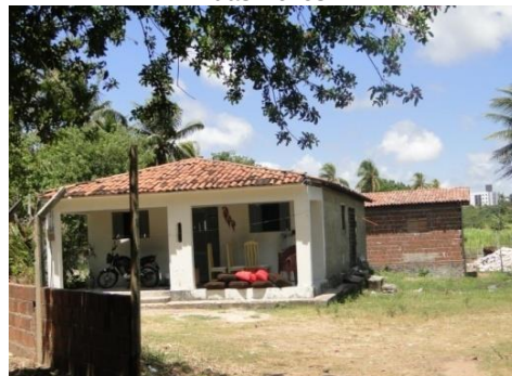
Figura 3.39 - Residências - No 2º plano residência construída em 2013. Rua sem nome perpendicular a Rua Sebastião R. de Melo, João Pessoa-PB.
