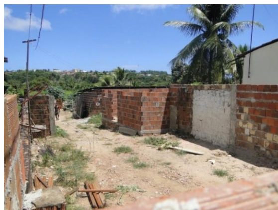
Figura 56 - Construção de novas habitações. Comunidade Frei Damião, João Pessoa – PB. Fonte: Anjos, 2013.
