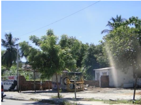
Figura 7.3 - Borracharia (Construída em 2013). Rua Manoel Furtado de Lacerda, João Pessoa-PB.
