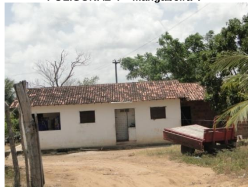
Figura 10.25 – Residência. Rua sem nome paralela a Estação de Tratamento de Esgoto da CAGEPA, João Pessoa-PB.
