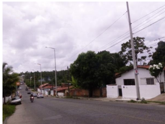
Figura 50 - Padrão residencial da rua Brasilino A. da Nóbrega, João Pessoa-PB. Fonte: Anjo, 2013.
