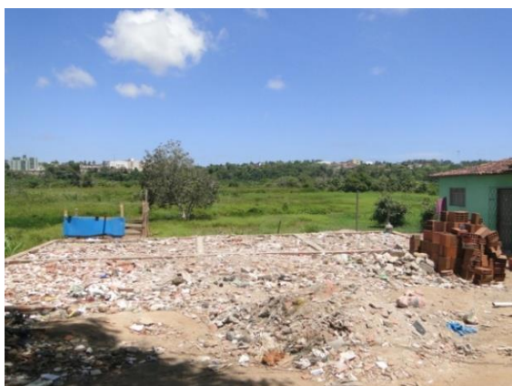
Figura 55 - Construção de alicerce para habitação. Comunidade Frei Damião, João Pessoa – PB. Fonte: Anjos, 2013
