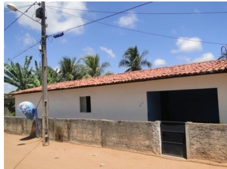
Figura 4.14 – Residência. Rua sem nome paralela ao rio Cuiá, João Pessoa-PB.
