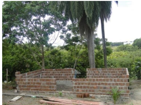
Figura 5.10 - Construção iniciada em 2013. Rua sem nome paralela aos rios Cuiá e Laranjeiras, João Pessoa-PB.
