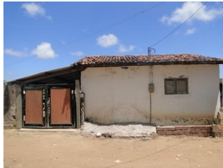
Figura 4.19 – Residência. Rua sem nome paralela ao rio Cuiá, João Pessoa-PB.
