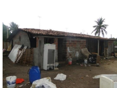
Figura 5.35 – Residência. Rua sem nome, localizada no centro da Comunidade. João Pessoa-PB.
