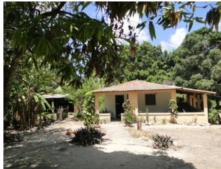
Figura 3.42 – Granja. Rua Sebastião Renato de Melo, João Pessoa-PB.
