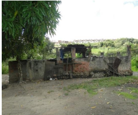
Figura 1.13 - Pocilga desativada construída na APP do rio Cuiá. Rua Cecília Furtado da Silva, Gramame, João Pessoa-PB.
