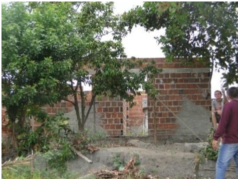
Figura 5.41 - Residência, construção iniciada em 2013, na margem do rio Cuiá, João Pessoa-PB.
