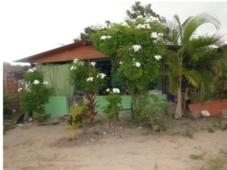
Figura 5.37 - Residência construída em APP. Rua sem nome, perpendicular a Rua Luiz T. de Souza, João Pessoa-PB.
