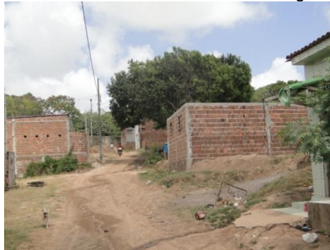
Figura 10.17 - Construções iniciadas em 2013. Rua principal da Comunidade, João Pessoa-PB.
