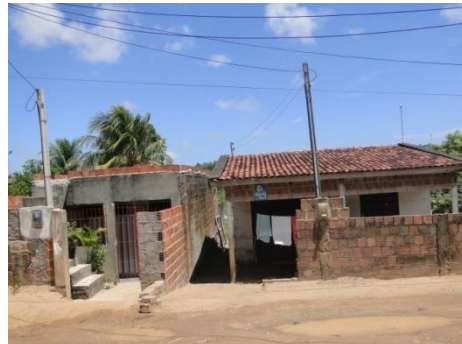
Figura 4.10 – Residências. Rua sem nome paralela ao rio Cuiá, João Pessoa-PB.
