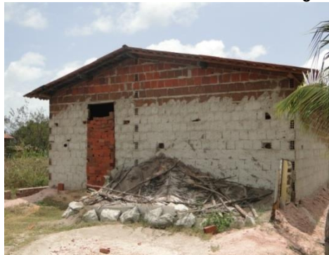
Figura 10.22 - Residência desocupada, construída em 2013. Rua sem nome, João Pessoa-PB.
