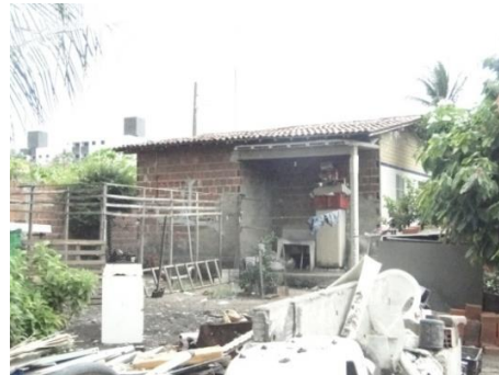
Figura 5.34 – Residência. Rua sem nome, localizada no centro da Comunidade. João Pessoa-PB.
