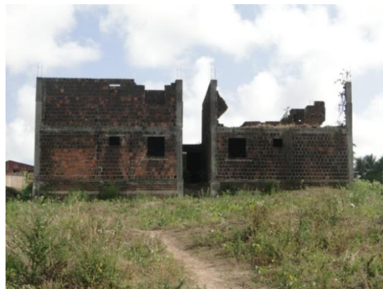
Figura 58 - Construção abandonada de prédio. Mangabeira V, João Pessoa-PB. Fonte: Anjos, 2013.
