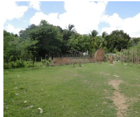
Figura 1.11 - Construção em ruínas na APP do rio Cuiá. Rua Cecília Furtado da Silva, Gramame, João Pessoa-PB.
