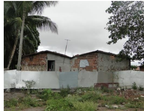
Figura 5.43 - Residências construídas na margem do rio Cuiá, João Pessoa-PB.
