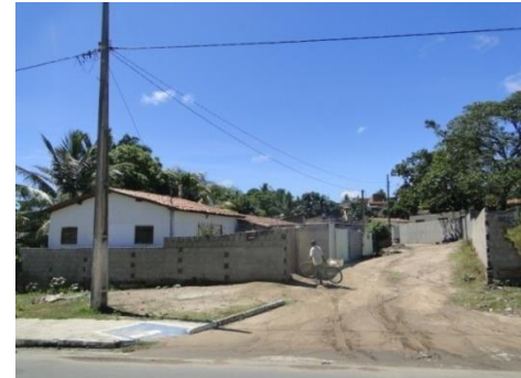
Figura 7.8 – Residências. Rua sem nome, perpendicular a Rua Manoel Furtado de Lacerda, João Pessoa-PB.
