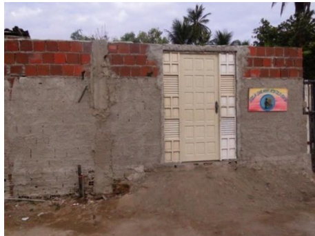
Figura 4.33 - Terreno murado. Rua sem nome perpendicular Rua Sebastião R. de Melo. João Pessoa-PB.
