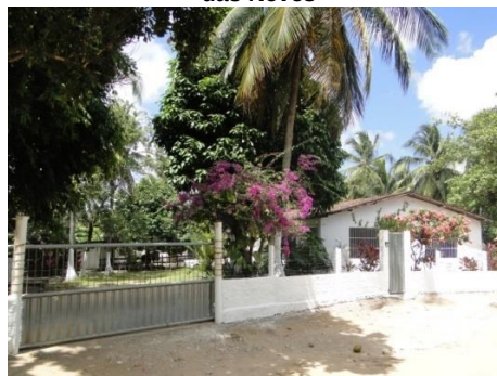
Figura 3.34 – Granja. Rua Sebastião Renato de Melo, João Pessoa-PB.
