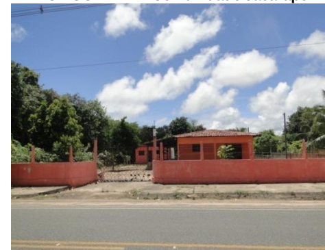
Figura 12.16 - Residência. Rodovia Ministro Abelardo Jurema, Jacarápé, João Pessoa-PB.
