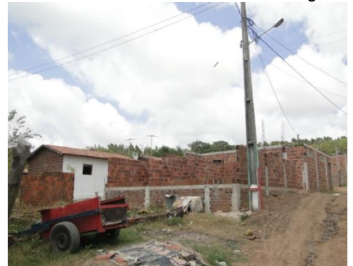
Figura 10.20 - Residências construídas em 2013. Rua Principal da Comunidade.
