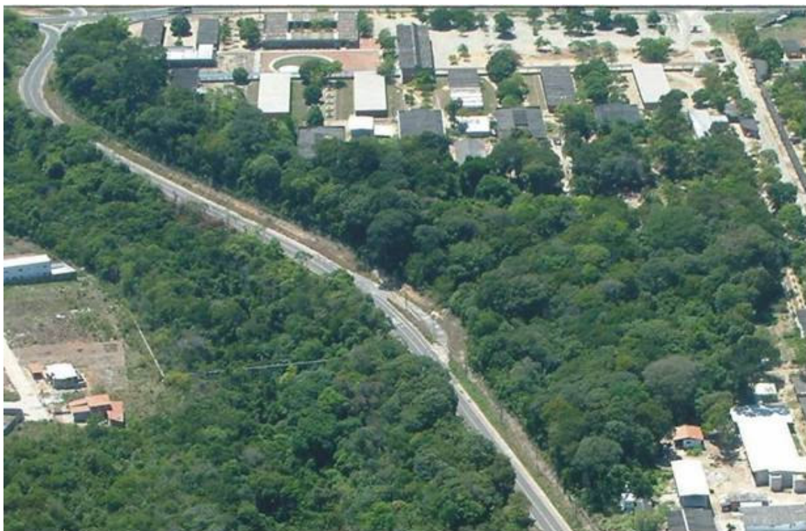
Figura - 4.2 Foto aérea do Centro de Tecnologia
