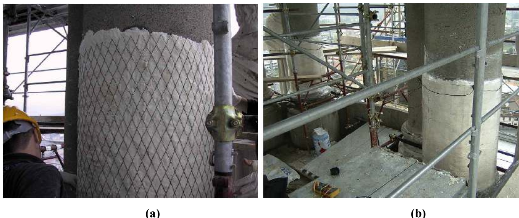
Figura 2.16 – Exemplo de aplicação da realcalinização eletroquímica em estrutura real: (a) malha de titânio ativado sobre uma primeira camada de fibra de celulose encharcada de solução de \text{Na}_2\text{CO}_3 e (b) coberto com uma segunda camada de fibra de celulose e finalmente selada com película de plástico (BERTOLINI, 2008).
