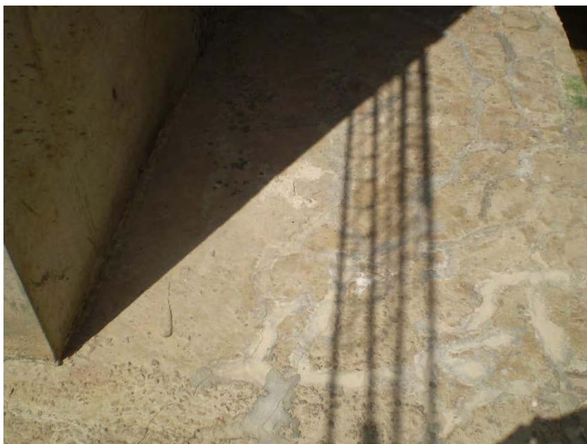
Figura 4.19 – Fissuras ativas na superfície do bloco 8 após preenchimento com epóxi.
