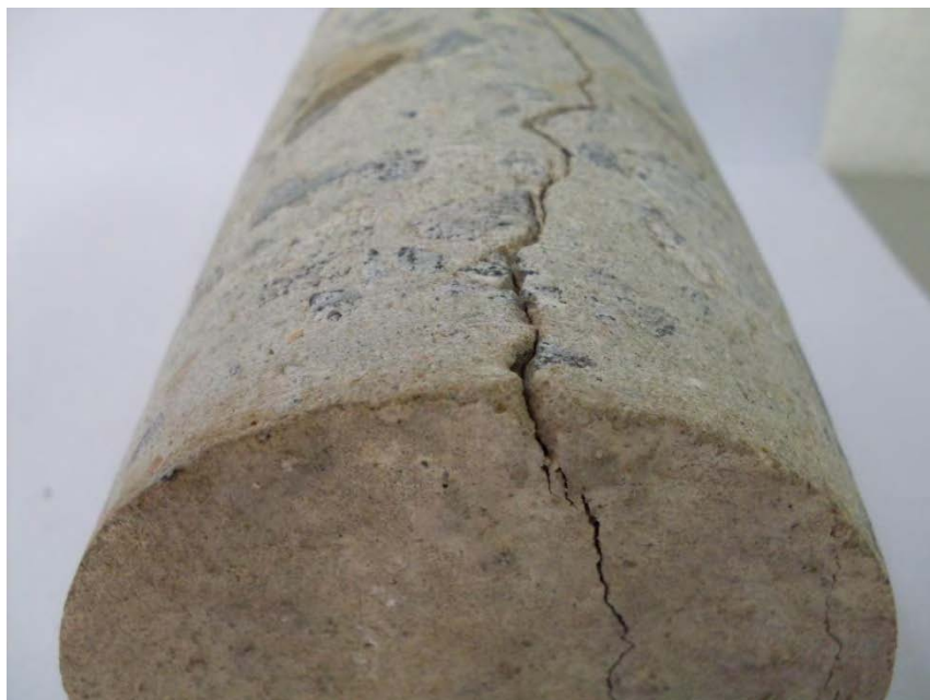
Figura 4.27 - Fissura penetra ao longo do testemunho do concreto do bloco 9.
