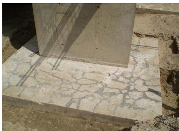
Figura 4.2 – Fissuras do bloco 7 preenchidas com epóxi
