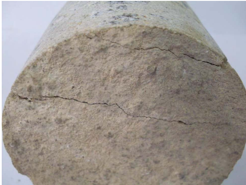
Figura 4.26 - Fissura discreta na superfície bloco 9.
