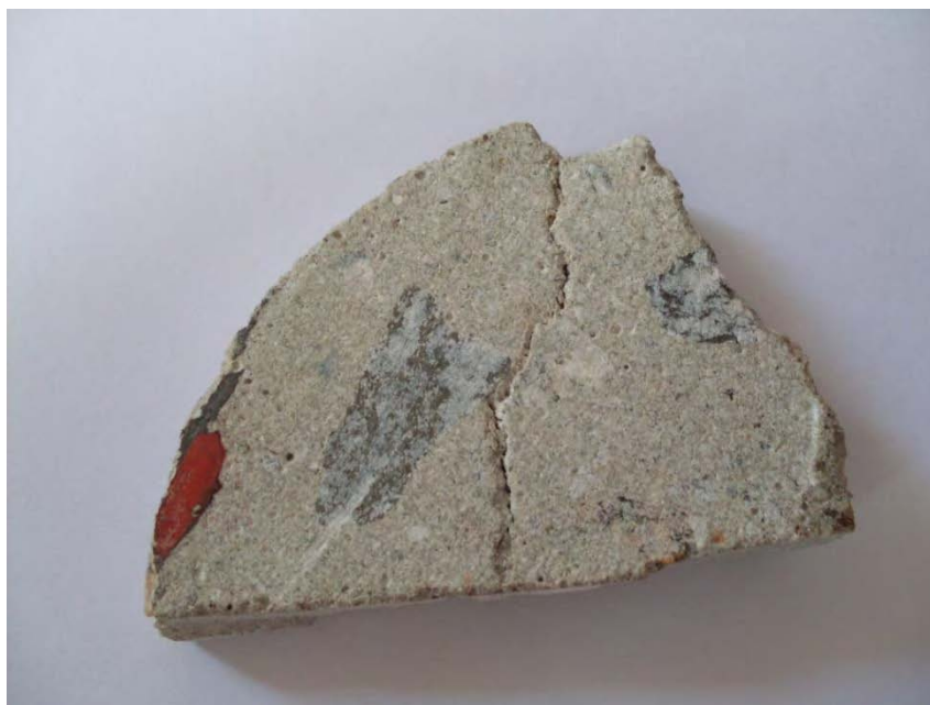
Figura 3.7 – Amostra de região fissurada no bloco 7
