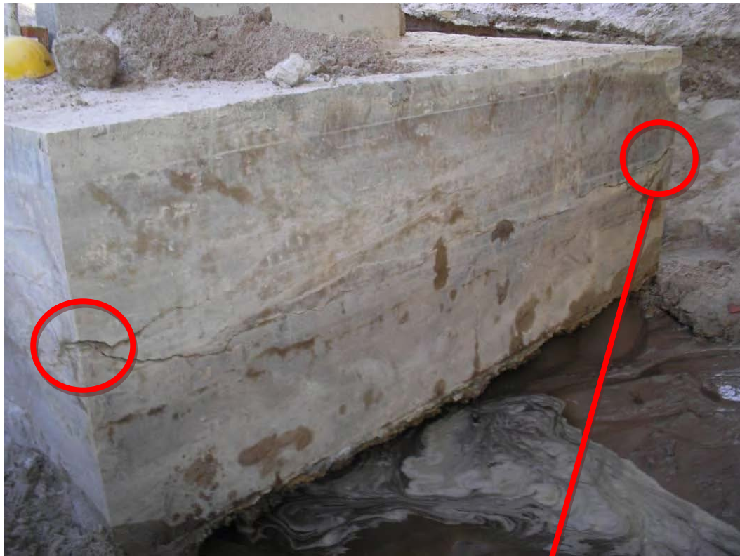
Figura 4.8 – Arestas do bloco 7.
