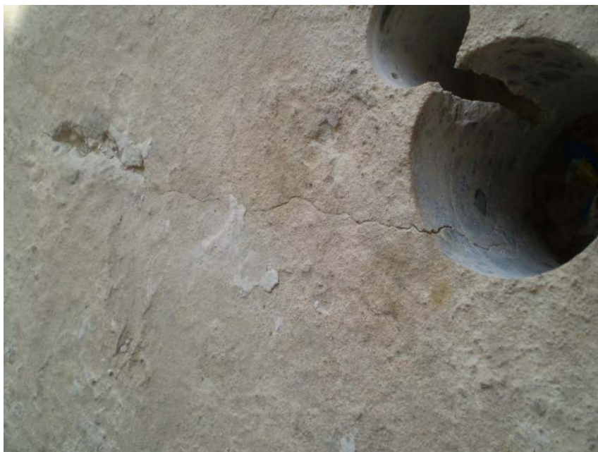
Figura 4.24 - Perfuração para extração de testemunho no bloco 9.
