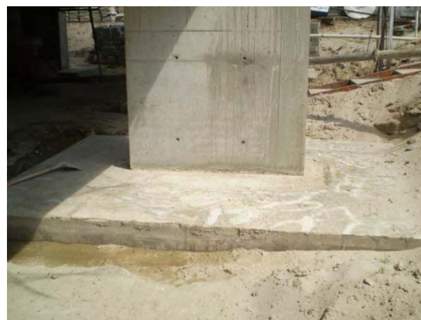
Figura 4.3– Fissuras do bloco 8 preenchidas com epóxi
