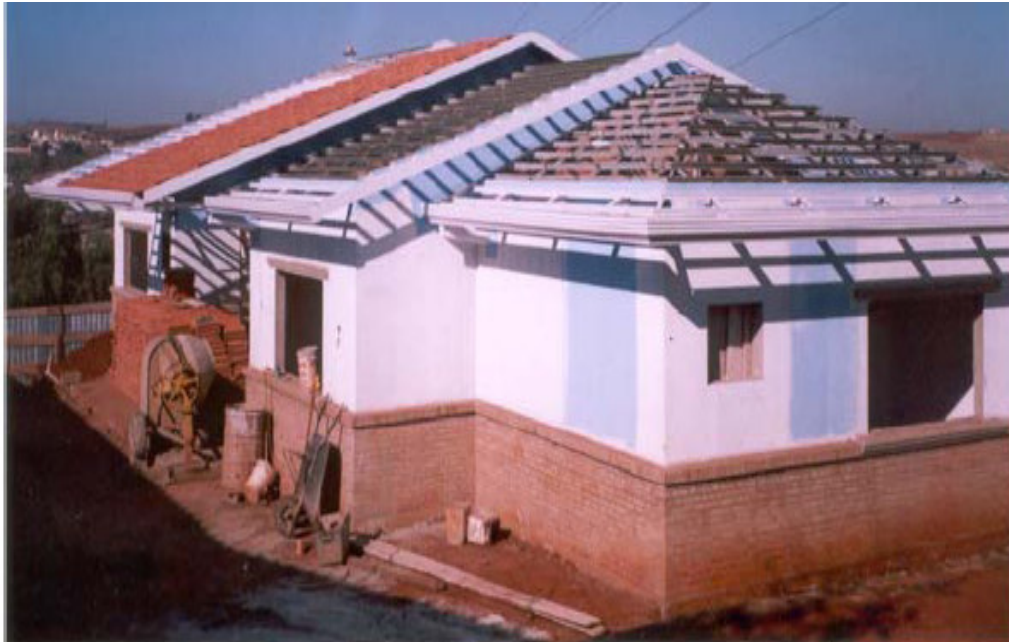
Figura 3.5 – Residência em Ribeirão Preto com aproveitamento de água pluvial.
