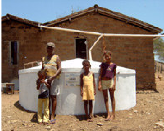
Figura 3.6 – Cisterna de placa de cimento.
