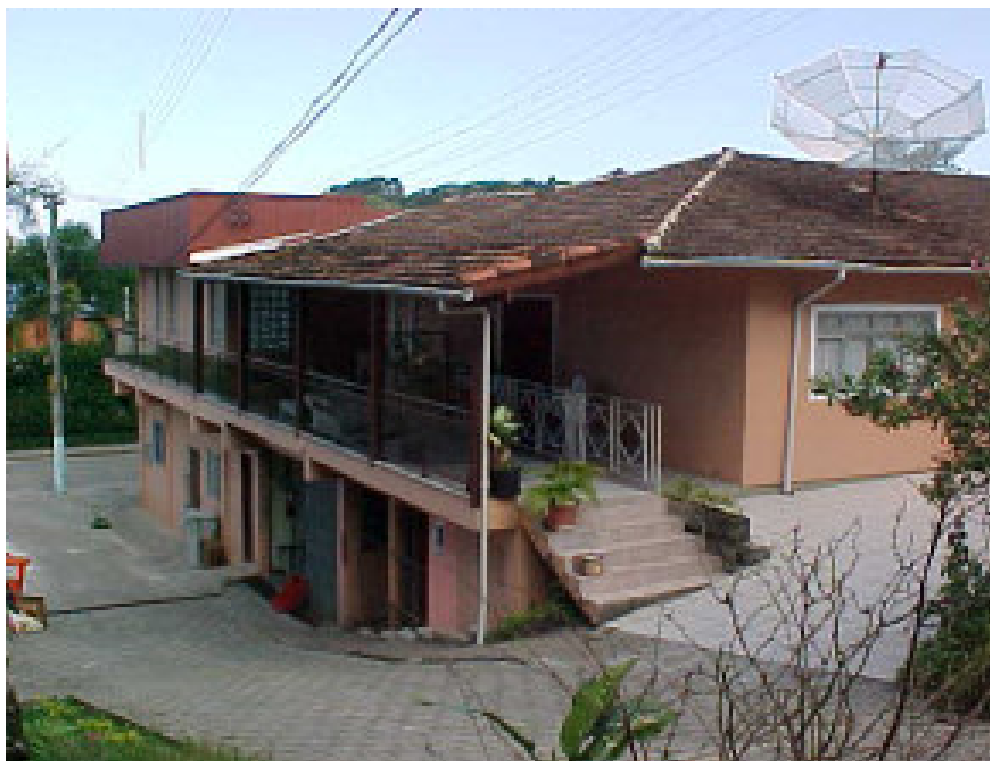
Figura 3.11 – Residência de telhado cerâmico onde foi realizada a coleta das amostras.
