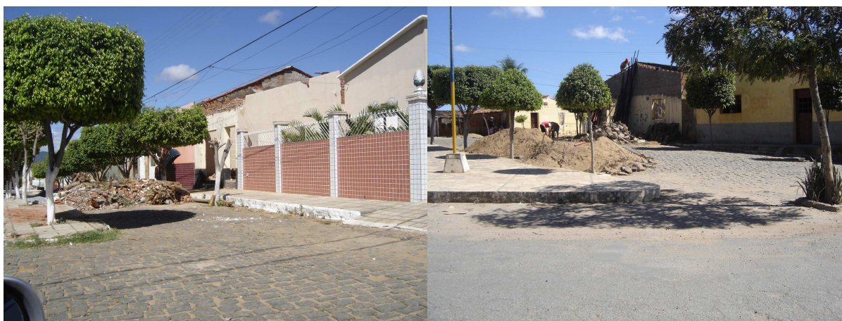
Figura 8: Aspecto visual de diversas vias obstruídas com RCC no município de Cachoeira dos Índios. Fonte: Arquivo do Autor.
