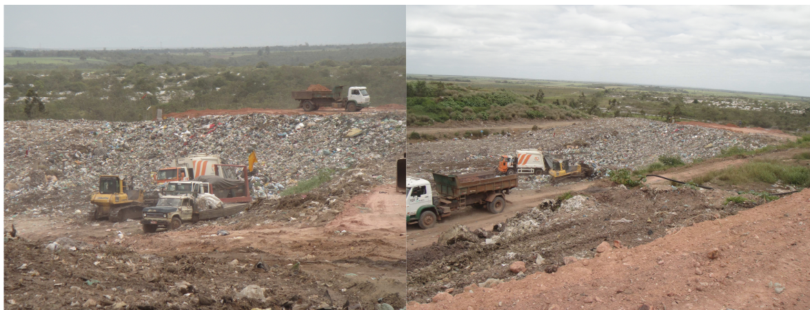
Figura 20: Aterro metropolitano de João Pessoa. Fonte: Arquivo do Autor.
