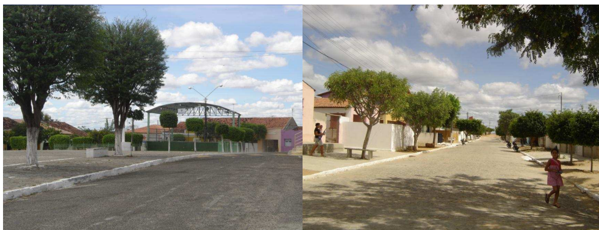
Figura 7: Aspecto geral das principais vias do município de Boa Vista. Fonte: Arquivo do Autor.
