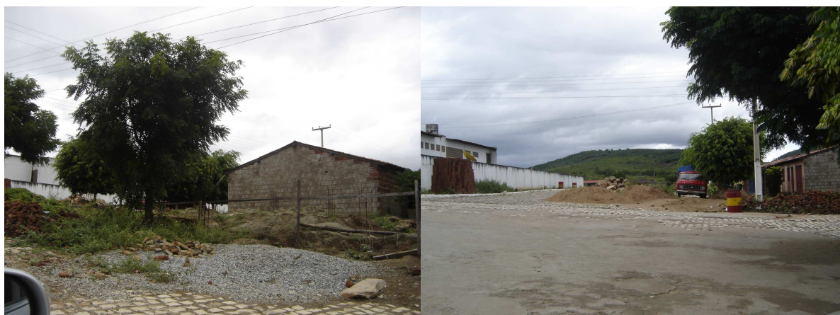
Figura 9: Existência de entulho de construção interditando vias da cidade de Poço Dantas. Fonte: Arquivo do Autor.
