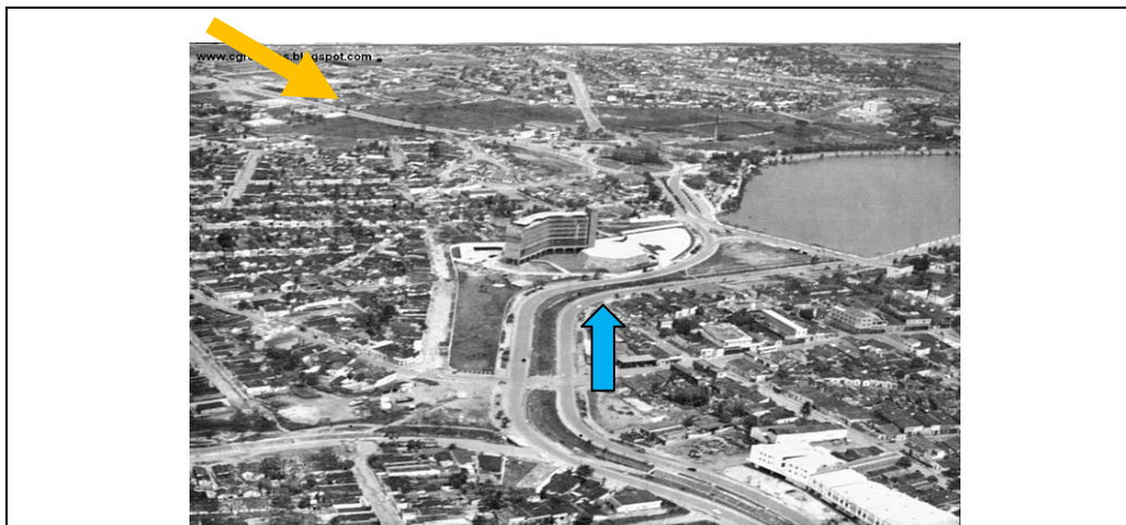
Figura 21 - Imagem panorâmica de Campina Grande no início dos anos 1980. Na parte direita da imagem, observa-se o Açude Velho. No centro, na seta azul, a “Avenida Canal”. No segundo plano da imagem, vê-se parte do Bairro do Catolé, em detalhe, na seta amarela, a Avenida Severino Cabral, ainda pouco ocupada. Fonte: [www.cgretalhos.blogspot.com] Acesso em 25/03/2010.
