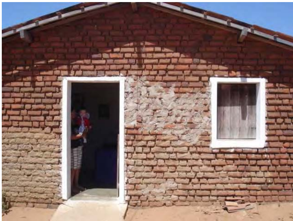
Figuras 27 – A casa de Dona Maria José em Lajedo de Timbauba, Soledade-PB. Fonte: Rute Vieira, agosto de 2010.
