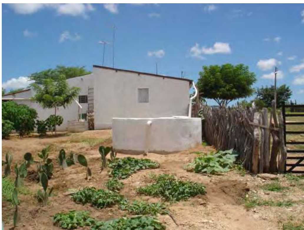
Figuras 25 – Cisterna de Placa: residência na comunidade com implementação da cisterna de placa. Lajedo de Timbauba, Soledade-PB. Fonte: Rute Vieira, março de 2009
