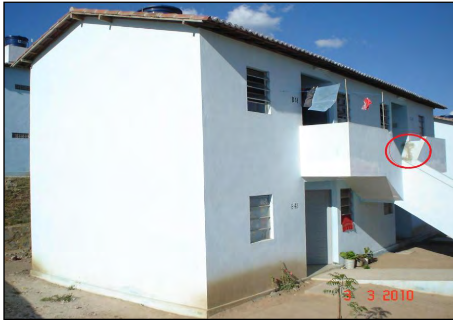
Foto 8: Problemas na construção das casas do Conjunto Araxá. Trabalho de Campo - março de 2010. LIMA, Yure Silva.
