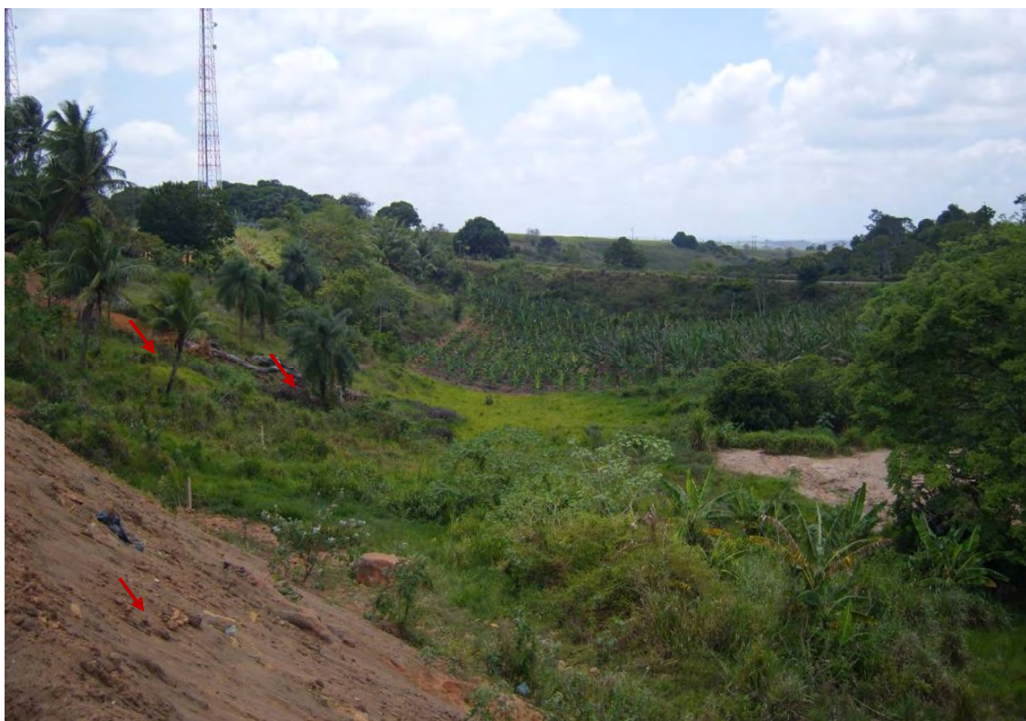
Foto 6.2 - Movimento de rastejo de solo ( soil creep ) em vertente de um afluente da margem esquerda do rio do Galo com declividade elevada, superior a 47%, verificado pelos caules inclinados dos coqueiros e pelo aspecto do solo exposto (Foto: MAX FURRIER, 2010).
