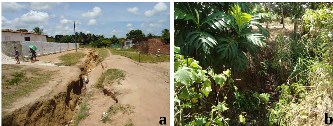
Foto - 6.5a – Voçoroca no bairro Nova Alhandra – Alhandra – PB, próxima de uma escola municipal e de casas residenciais (Foto: GILVONETE FREITAS, 2011) Foto - 6.5b – Voçoroca no bairro Bela Vista, área periférica em Alhandra – PB, nas proximidades da Pastoral da Criança (Foto: GILVONETE FREITAS, 2011).
