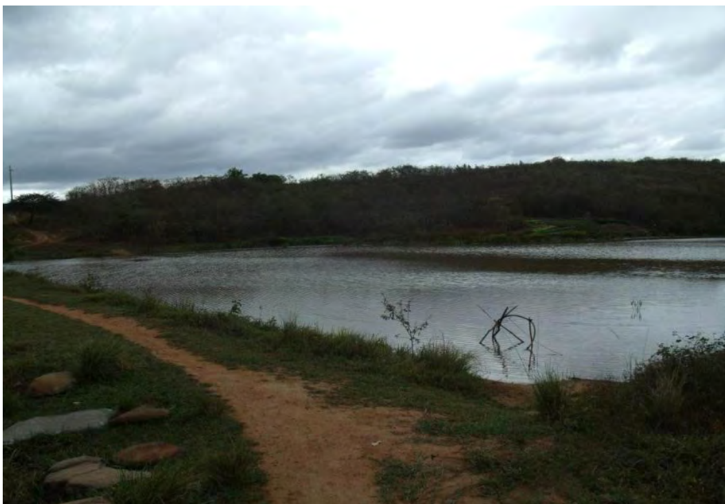
Fotografia 18: Açude comunitário, açude de todos
