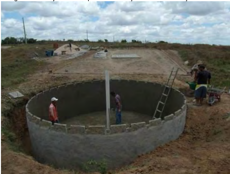
Fotografia 27: A ajuda mútua para a construção da cisterna calçadão.
