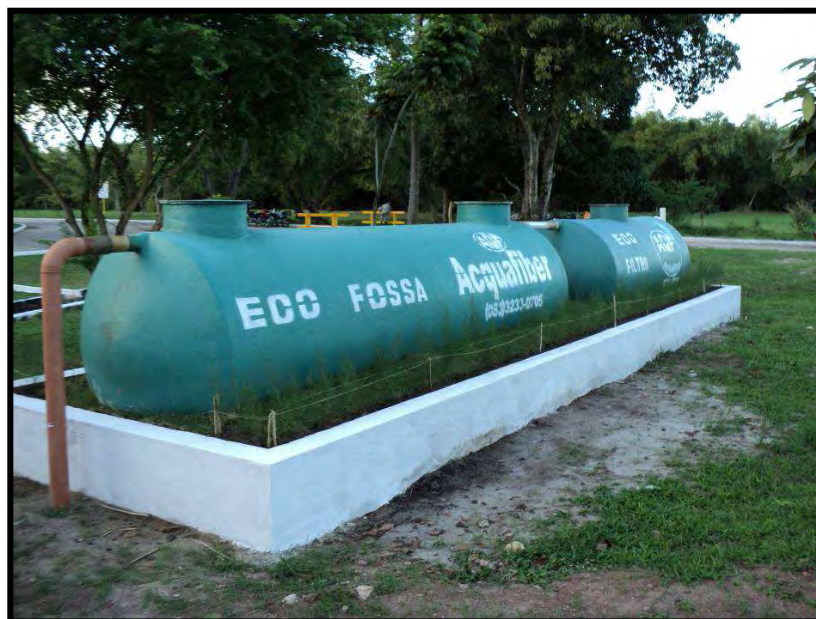
Figura 3.58 - Sistema de tratamento dos efluentes sanitários originários do refeitório da empresa (Foto: PRAD/2010).
