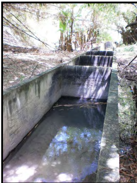
Figura 3.59 – Sistema Separador de água e óleo da drenagem da fábrica, construído em concreto armado e alvenaria, dotado de clincanas para a contenção dos sólidos, óleos e graxas. (Foto: PRAD/2010).
