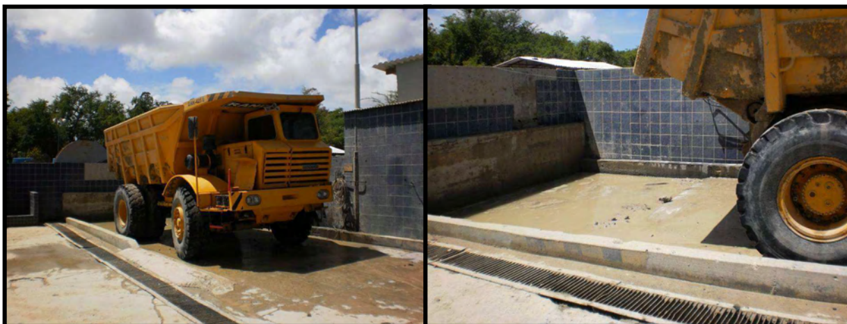
Figura 3.55 – Lavador de máquinas/veículos com caixa de decantação de areia para tratamento do efluente imediatamente após a lavagem (Foto: PRAD/2010).
