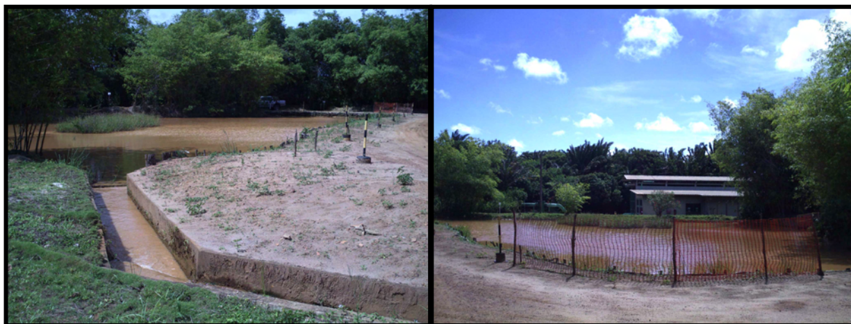
Figura 3.4 – Vala de transporte de efluentes para a bacia de decantação (Foto: Autor/2011).
