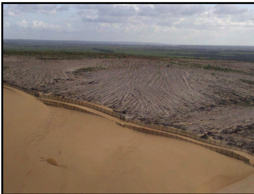
Figura 3.14 – Disposição da camada de solo orgânico em área minerada (Foto: Autor/2008).
