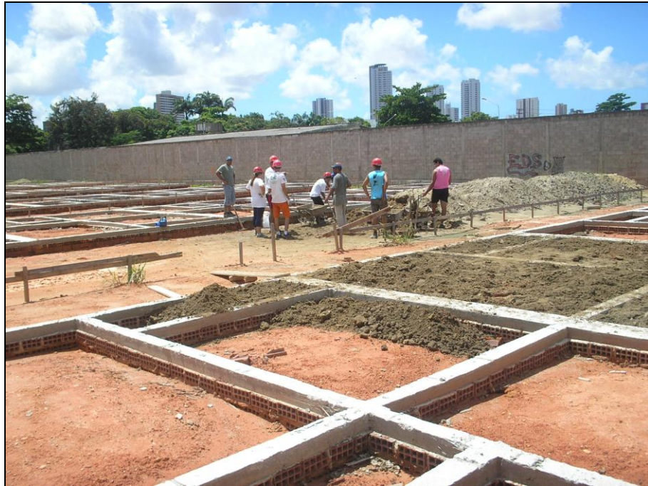
Figura 23: Construção das bases das moradias pelas famílias
