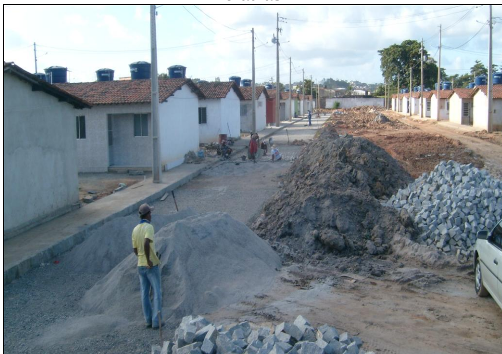
Figura 27: Obra em processo de finalização de construção das moradias
