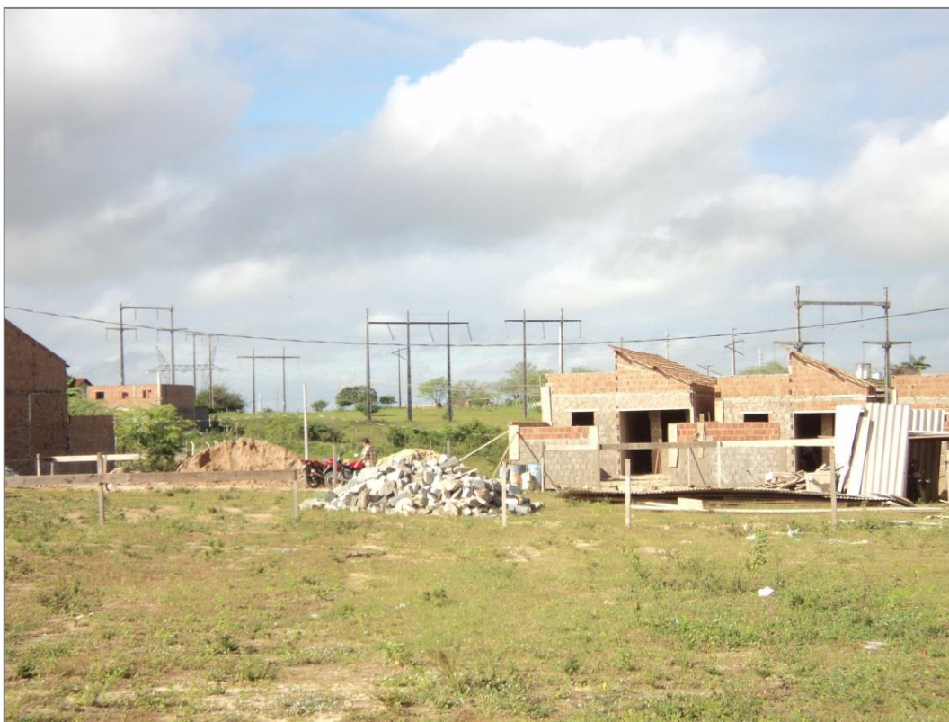
Figura 20 – Loteamento e moradias sendo construídas entre a rede de alta tensão e a malha urbana, no Bairro Acácio Figueiredo, aproveitando espaços não edificados que restaram de antigas propriedades rurais.
