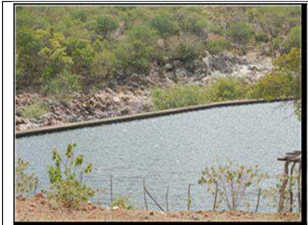
Figura 20- Tanque de pedra Umarizal-RN. Fonte: Allana Coutinho (2010)
