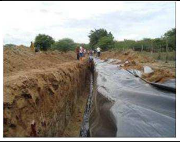
Figura 19- Construção da Barragem subterrânea Fonte: Arquivo ASPTA
