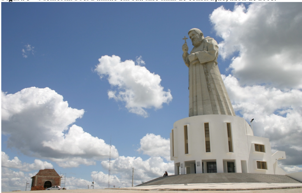
Figura 3 – Memorial Frei Damião em sua fase final de construção, abril de 2008.
