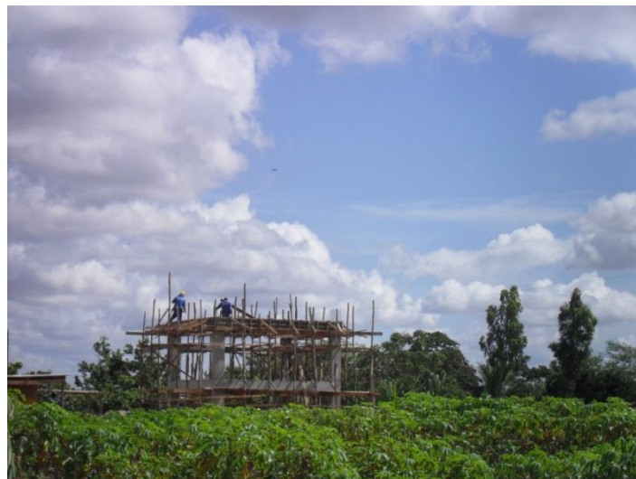
Fotografia 3- Caixa D'água em Construção no PA Tiradentes
