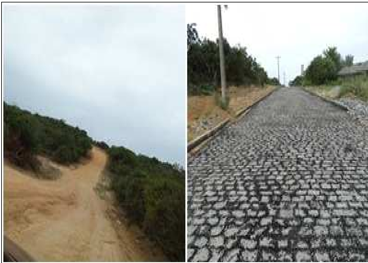
Figura 21 – Acesso interno antigo e novo (em construção) à praia de Coqueirinho, nos anos de 2012 e 2014 – Conde-PB
