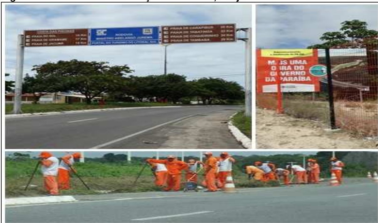
Figura 12 – Obras de manutenção da PB-008, em julho de 2014.
