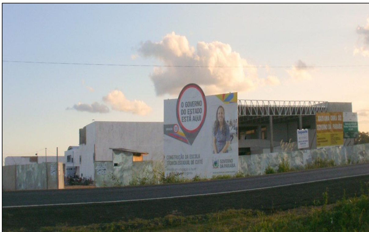
Figura 15 - Construção do prédio da Escola Técnica Estadual de Cuité, 2014.
