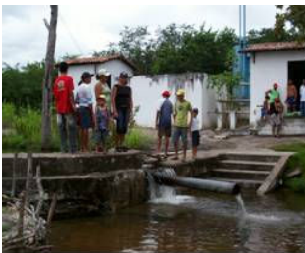
Figura 08: Estação de captação de água para abastecer as comunidades vizinhas ao assentamento Mata Verde.
